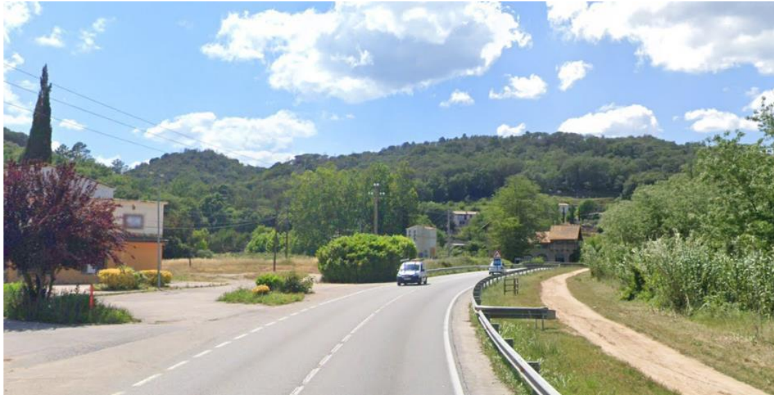
Il·lustració 27. Infraestructures existents a l'àmbit d'actuació (Font: elaboració pròpia. Any 2021)
