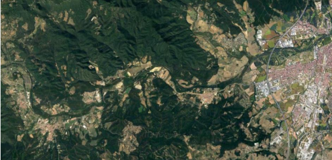
Il·lustració 24. Vista general de l'àmbit d'actuació (Font: elaboració pròpia. Any 2021)
