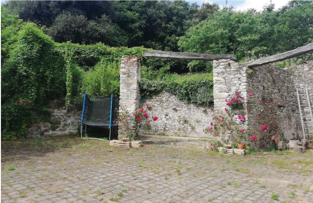
Coberts principals: volum del costat sud.
