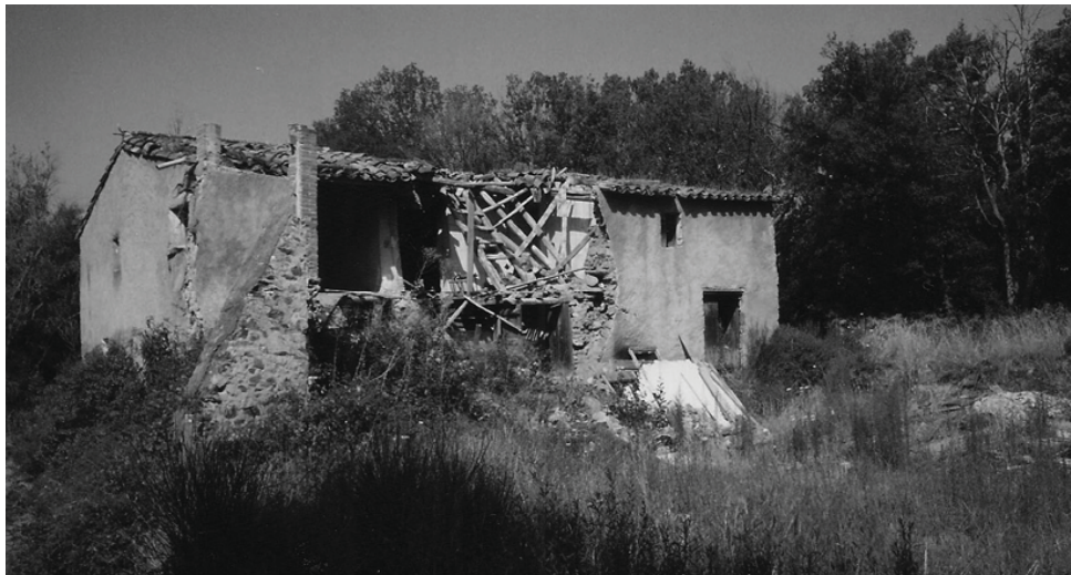
Façana est (façana principal)
