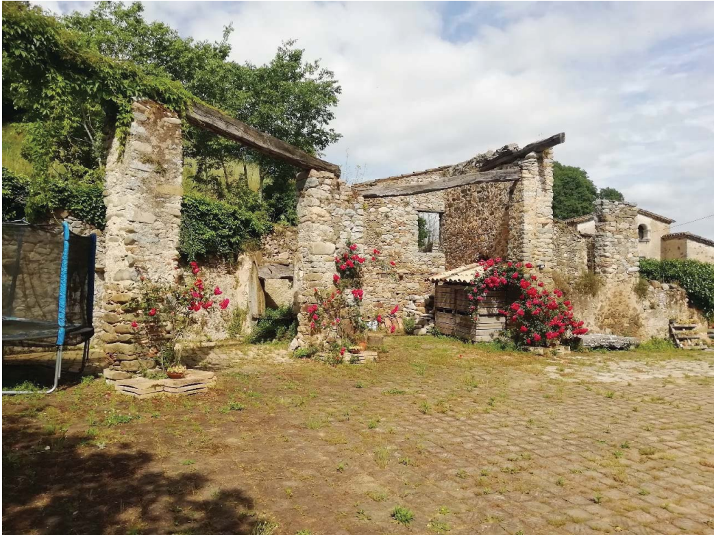
Coberts principals: imatge del conjunt dels volums que envolten l'era
