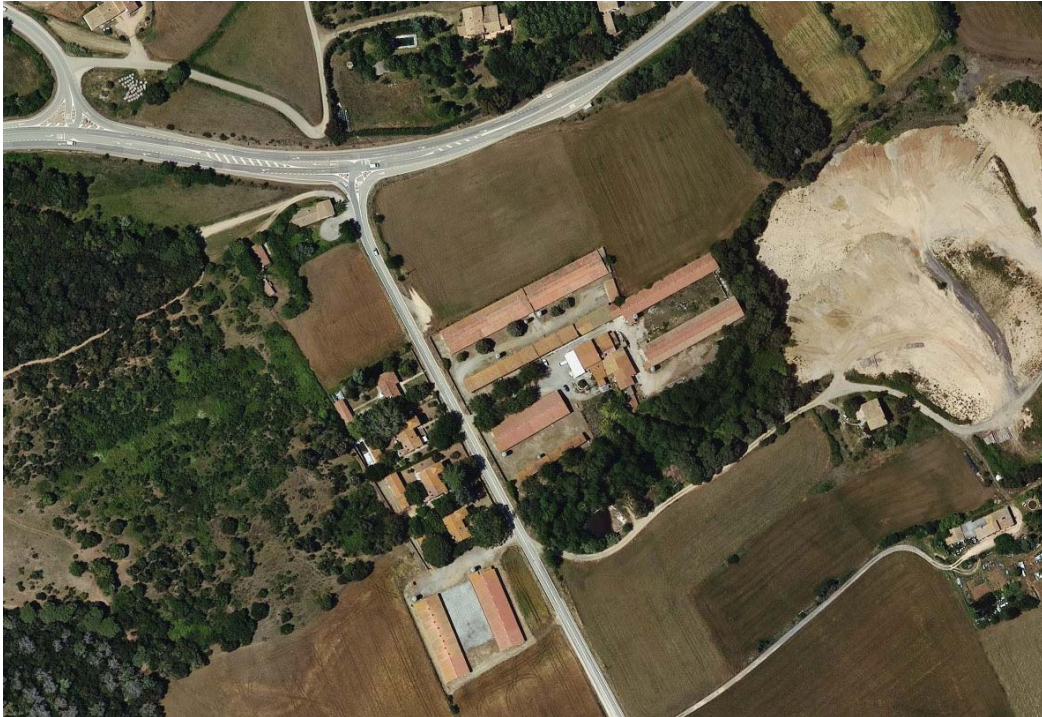
En aquest ortofoto es pot observar l'explotació principal ubicada al costat est de la carretera GI-534, i les dues naus ubicades al costat oest de la carretera, als peus del volcà de la Crosa.
