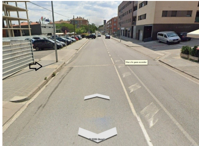
Vista de la canalització executada.
