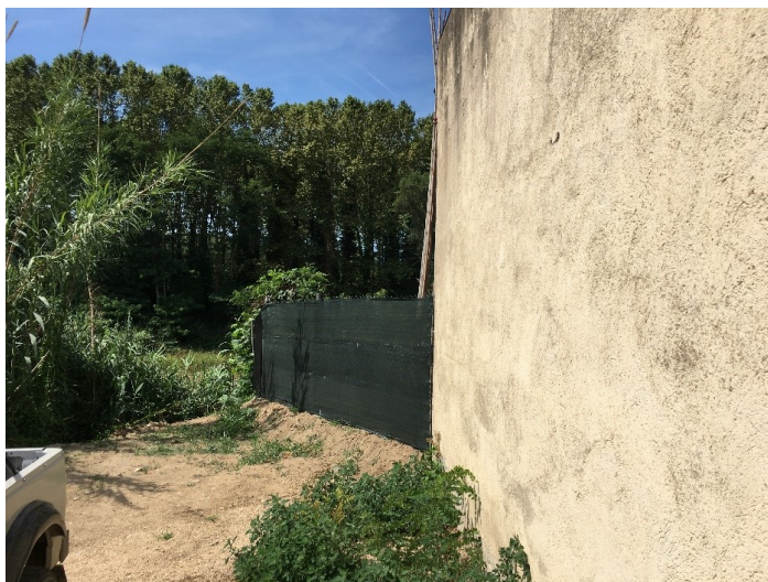
Vista de l'obra executada"
