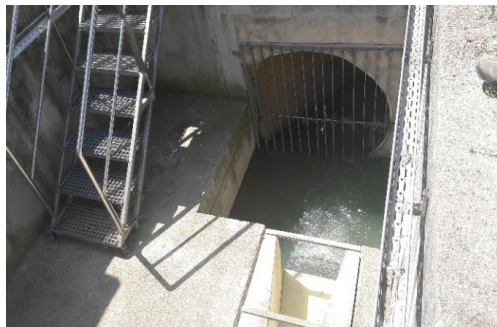
Figura 3. Reixa manual abans sortida aigües
