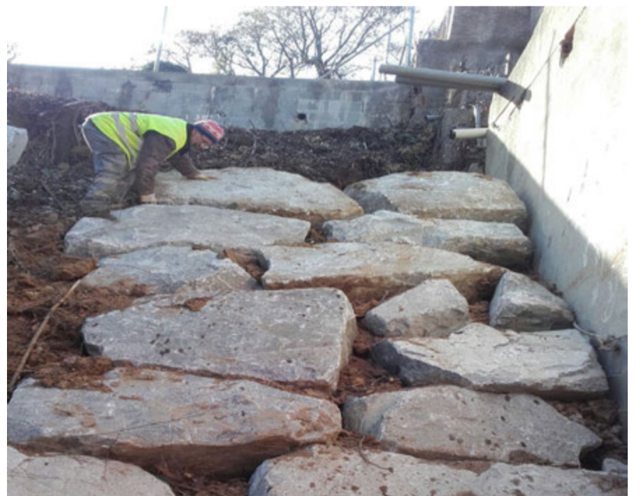
Reforçament de paret i col·locació de rocalla al c/ Isabel la Catòlica.
