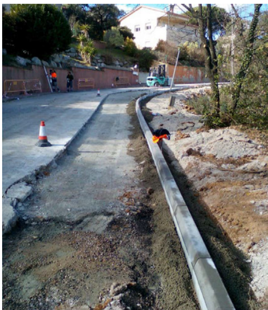
Reparació de blandons al c/ Turó de Berenguer.
