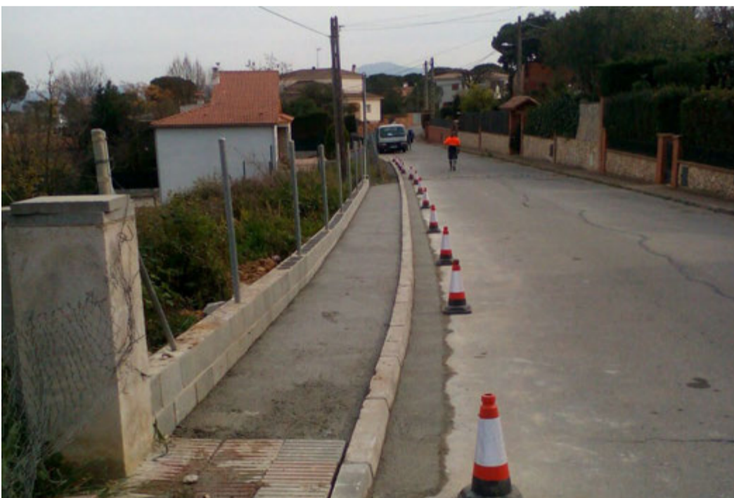
Subjecció, reforçament i pavimentació de la vorera al c/ de l'Hermita.
