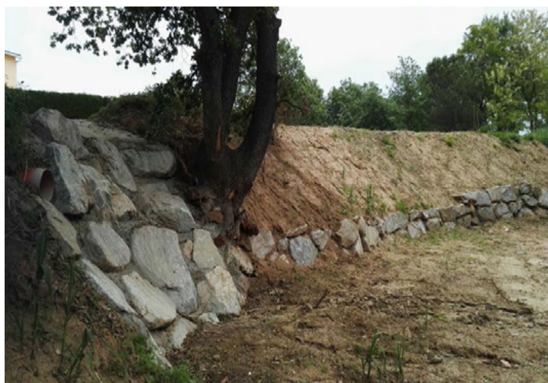
Reforçament d'escullera amb rocalla per la subjecció del clavegueram i recollida d'aigües fluvials del c/ Guilleries.
