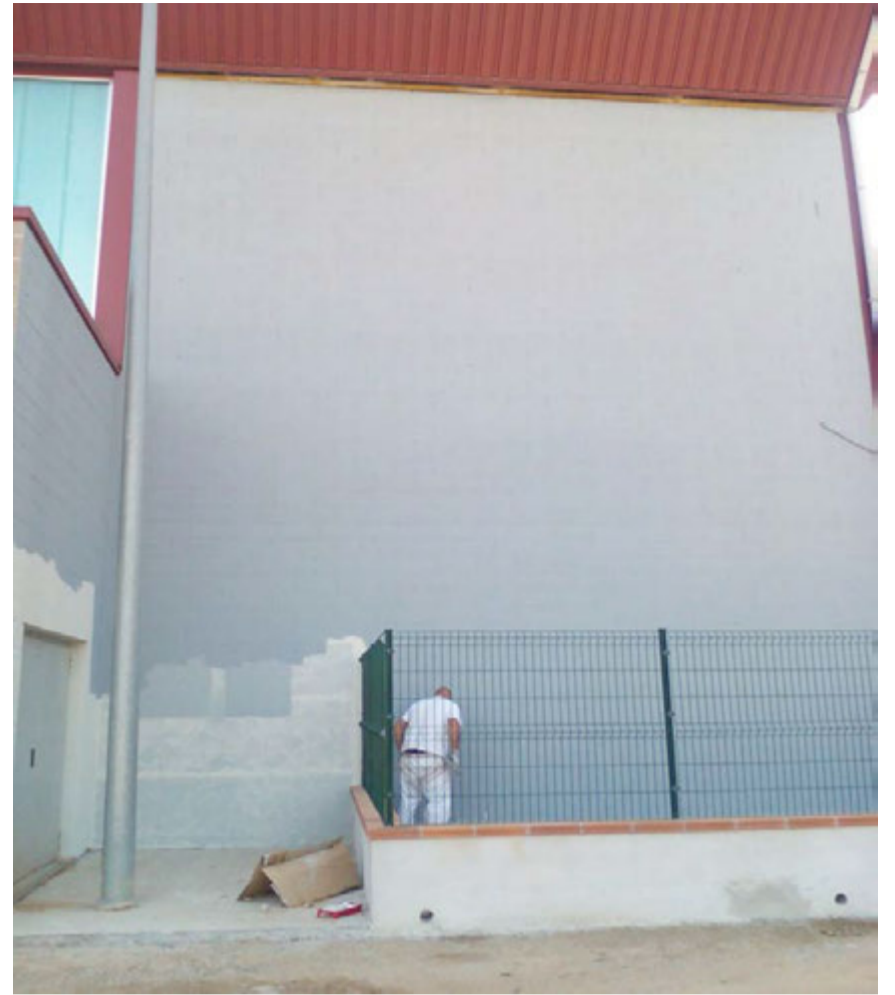
Obra de construcció, tancament, pintat i col·locació de preses del rocòdrom.
