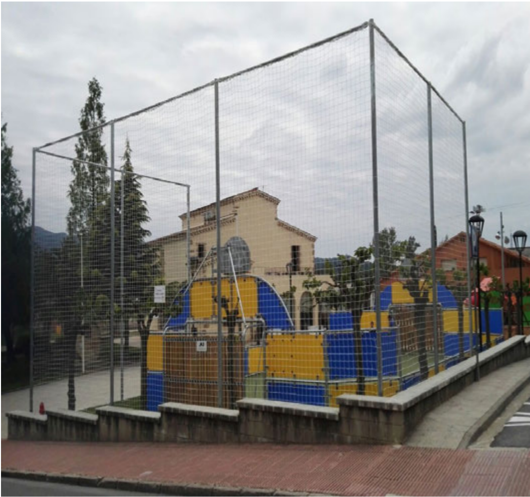
Col·locació de xarxa de protecció en el camp de multiesport.
