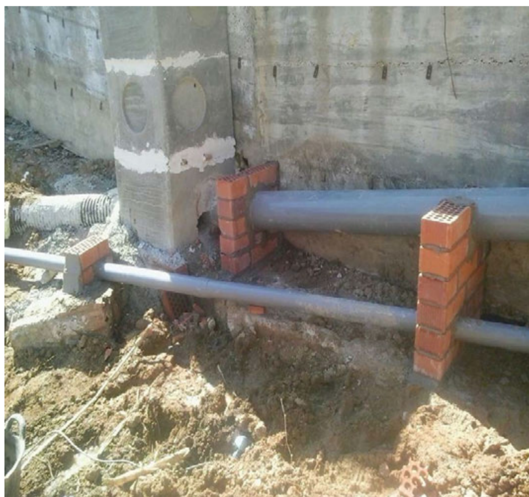
Conexió de claveguera i aigües fluvials per la zona verda entre el c/ Miguel Angel i c/ Mozart.
