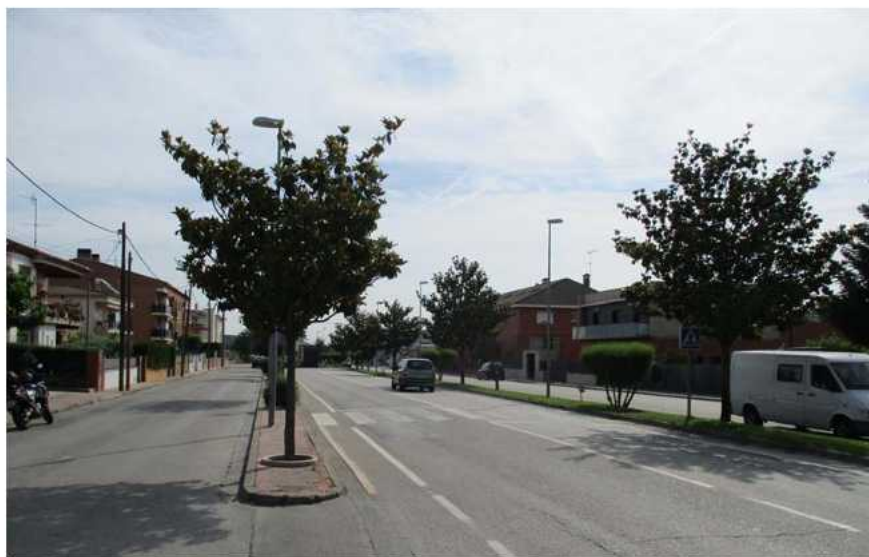
Vista del pas de vianants de la GI-552 des de la cruïlla amb carrer Riells.
