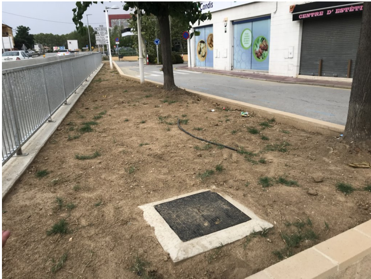
Foto 3. Parterre costat rampa d'accés de persones en pas soterrat a la C-35.
