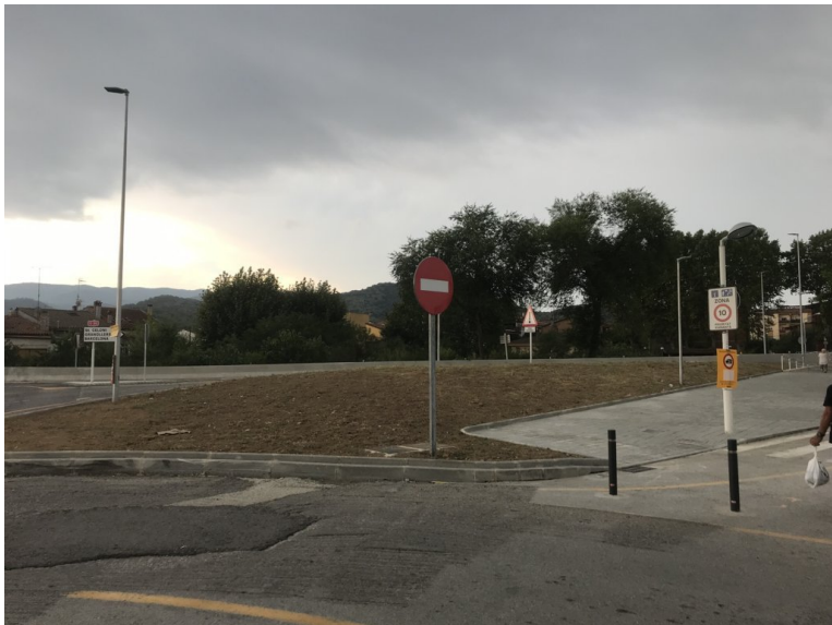
Foto 6. Accés a l'àmbit des del vial de sortida del nou giratori.
