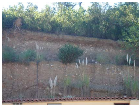
Fig.12. Talud cercano excavado en la que se puede observar la disposición de las unidades.
