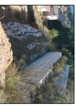
FOTO 2. Sistema de muros de contención de P-713.
