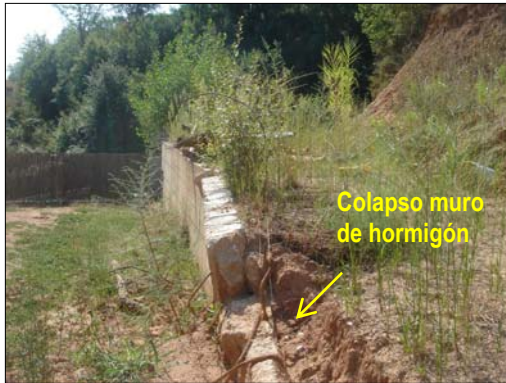
Fig.10. Muro de pie de hormigón armado. P-714. Fig.11. Muro de pie de escollera. P-713.
