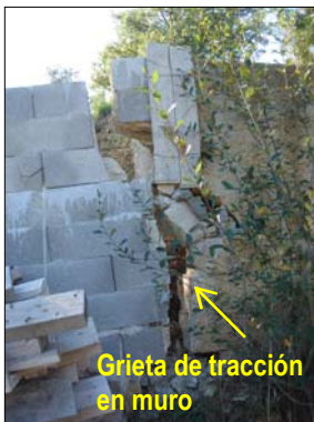
Fig. 7. Grieta de tracción en muro. Fig. 8. Vista del muro perimetral de la P-704. Fig. 9. Árbol a contrapendiente.
