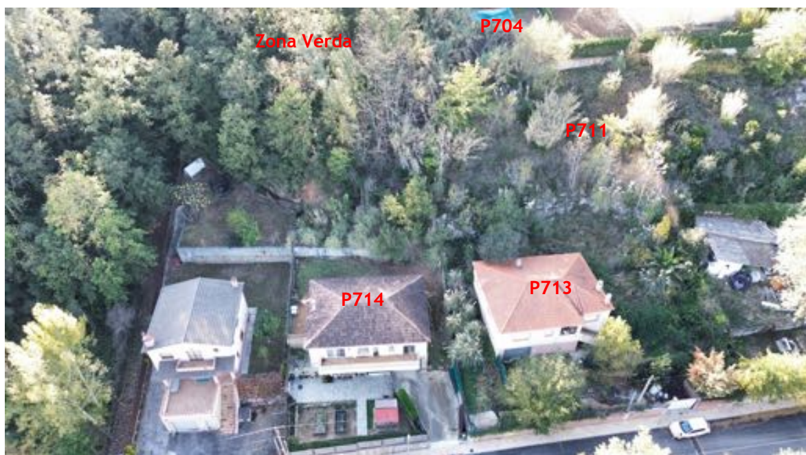
IMATGE 5. Foto aèria localització coronació àrea d'actuació. Parcel·les P713-P14. Data: 23/11/2023.
