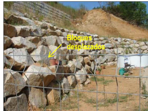
Fig.10. Muro de pie de hormigón armado. P-714. Fig.11. Muro de pie de escollera. P-713.
