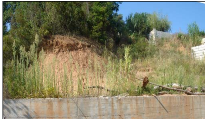
Fig.4. Vista frontal del talud desde la parcela P-714.
