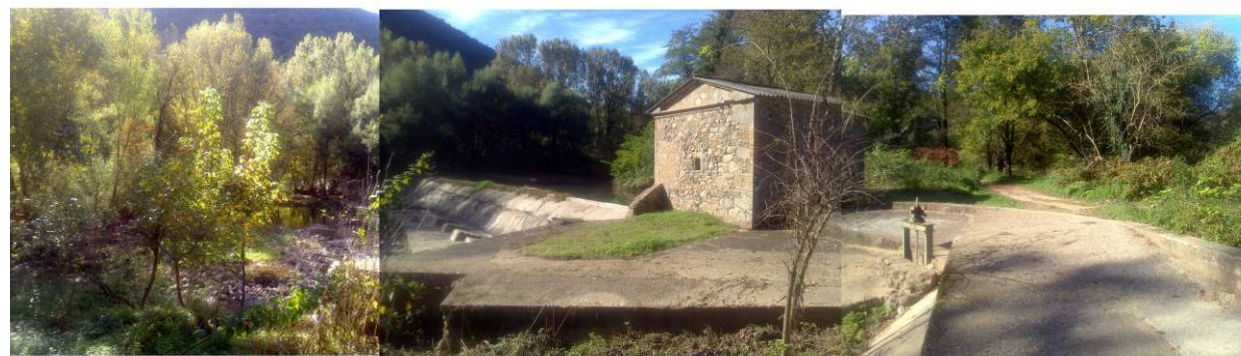
Foto: Resclosa de Sant Jaume. Font: Elaboració pròpia
