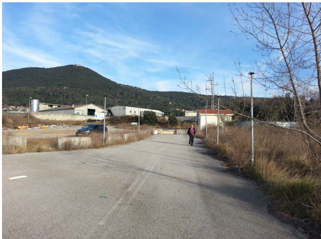
Vista de l'accés des de la benzinera
