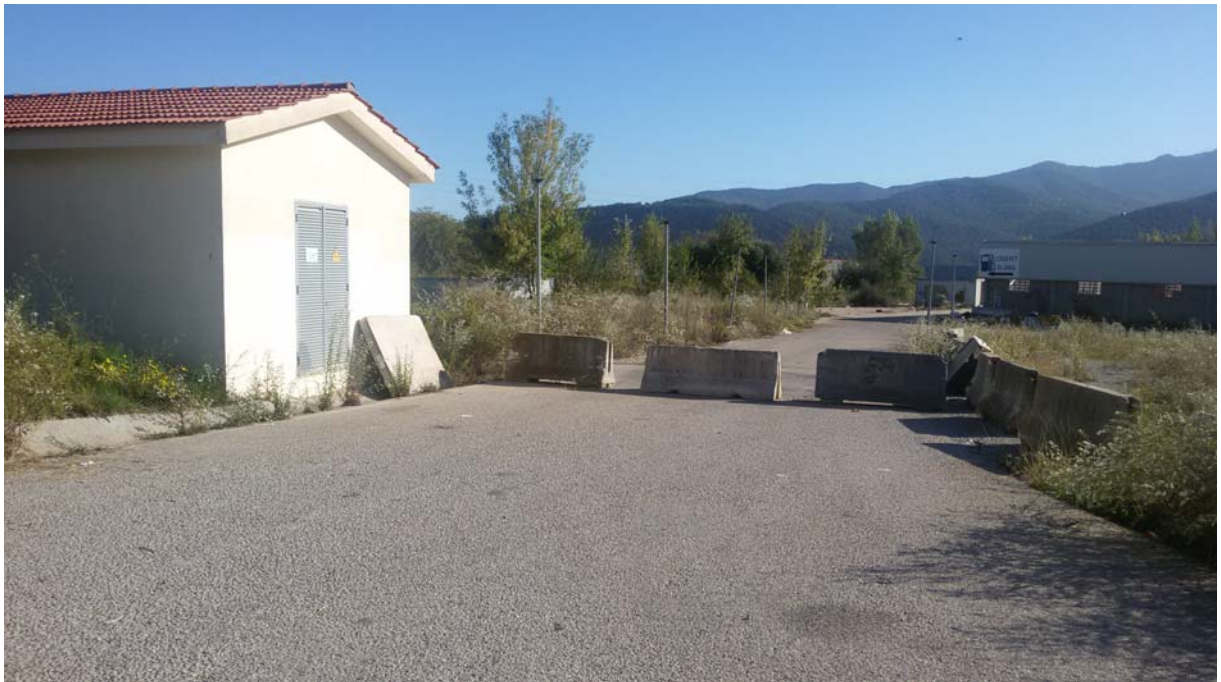
Fotografia accés des de l'antiga N-260z i estació transformadora
