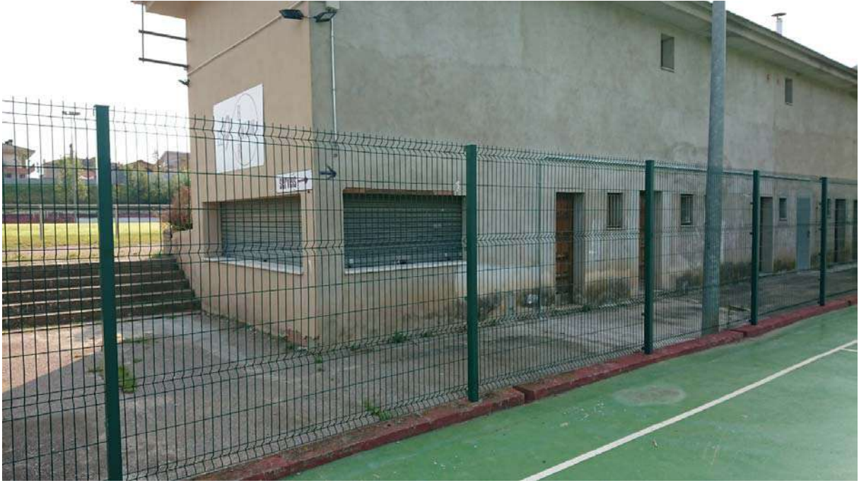
Imatge 5: Vestuaris, presa exterior d'aigua potable.
