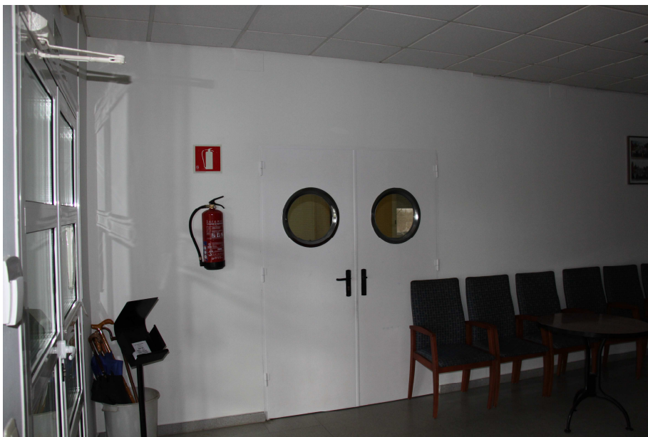
FOTO 17.-Entrada principal amb portes de sectorització metàl·liques i extintor portàtil.
