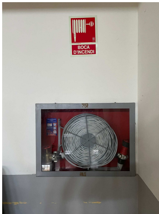
FOTO 11.-Detall Boca d'incendis equipada.
