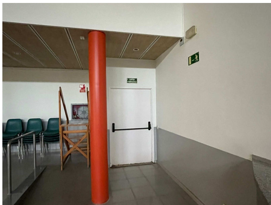
FOTO 10.-Sortida d'emergència amb rètol i llum d'emergència i boca d'incendis senyalitzada.
