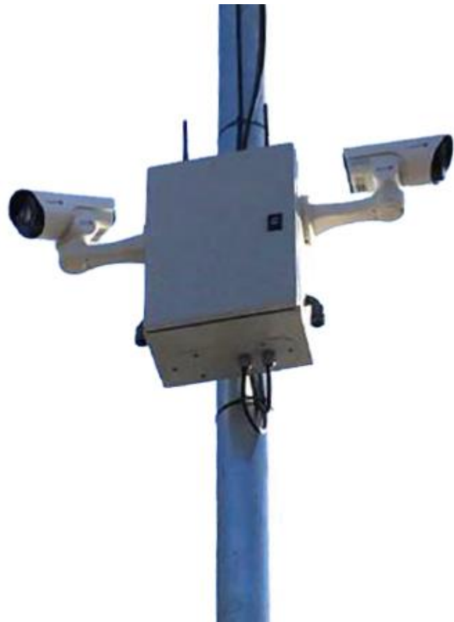
Il·lustració 18: Armari de fibra mecanitzat de 530x430x200 mm
