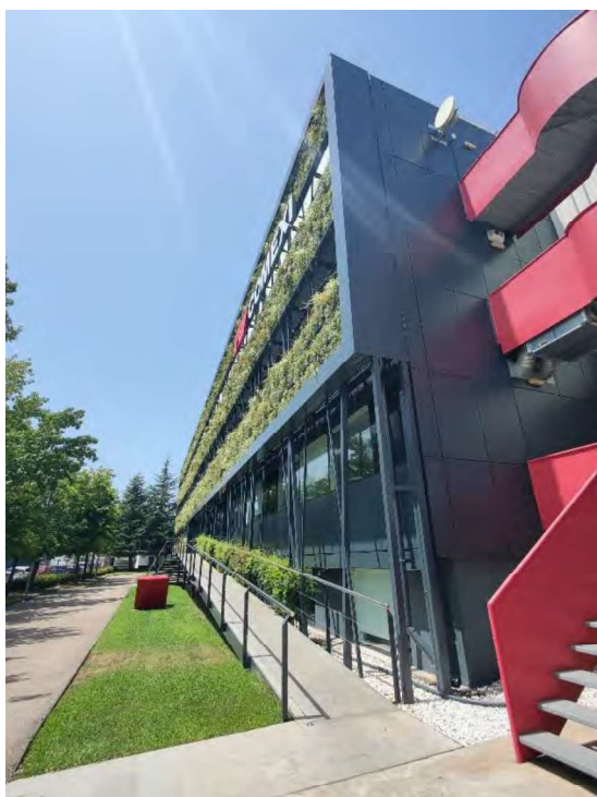
Façana sud – edifici d'oficines
