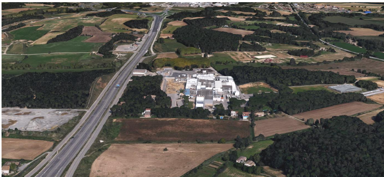
Imatge 6: Vista de la topografia de la zona de treballs a Riudellots de la Selva.
