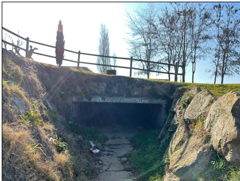
Figura 5. Vista aigua amunt del pont de la C-25
