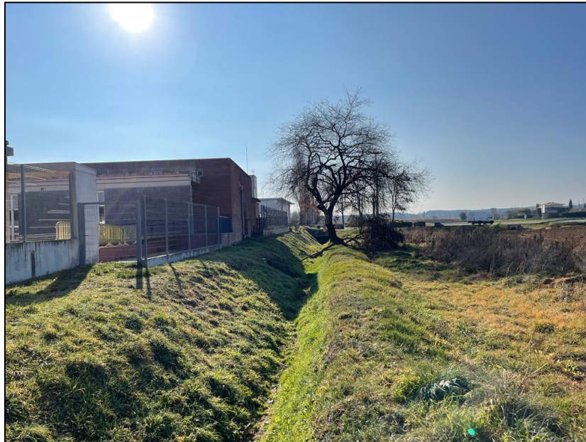
Figura 4. Llera del rec de Cal Queco aigua amunt del pont de la C-25, en direcció aigua avall
