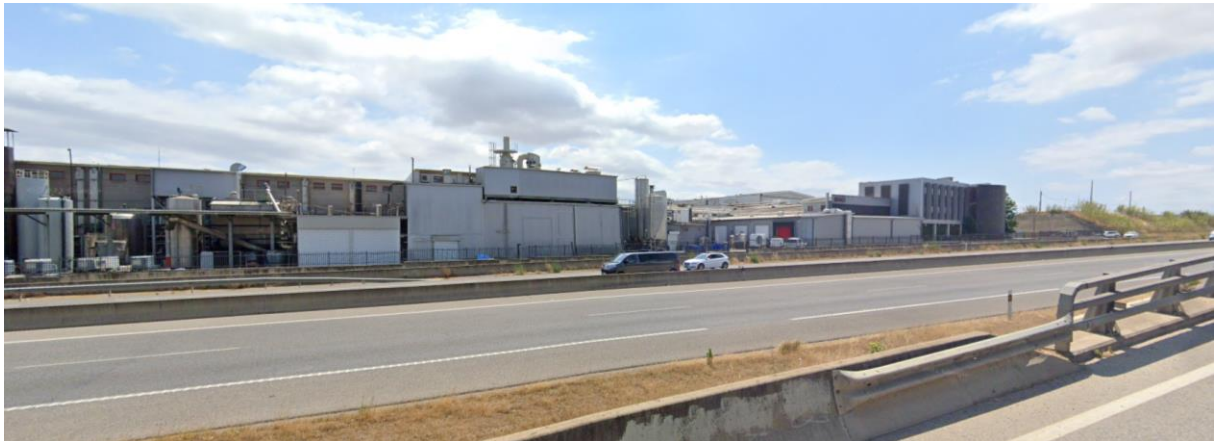
Figura 35: Vista de les instal·lacions de Friselva des de la via de servei situada a l'altre costat de la A-2.
