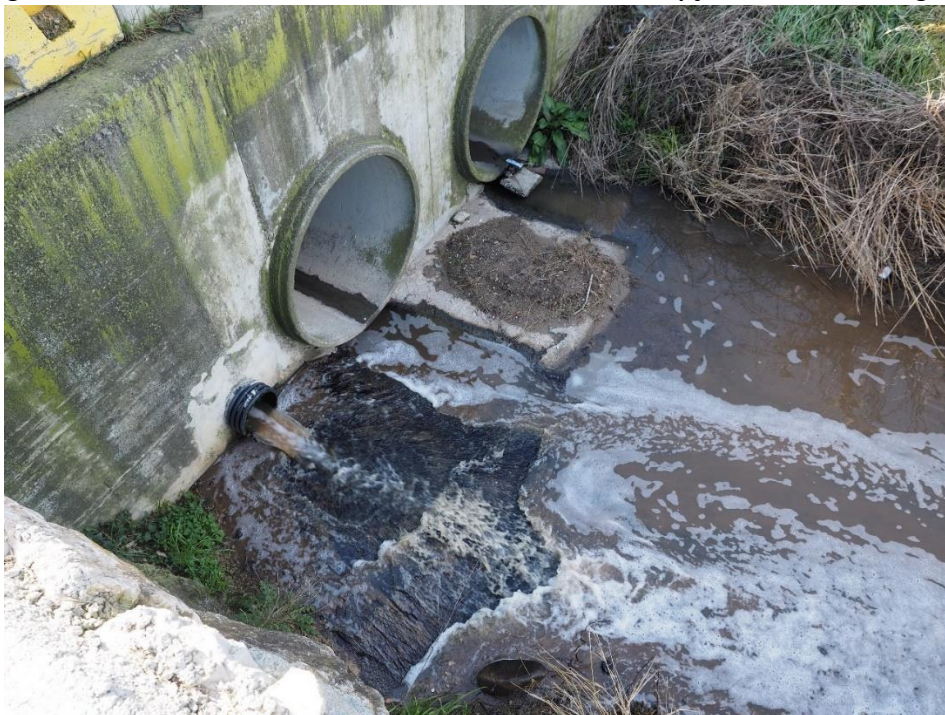
Figura 14: Punt d'abocament del col·lector de FRISELVA a la Capçalera del rec del Regàs.
