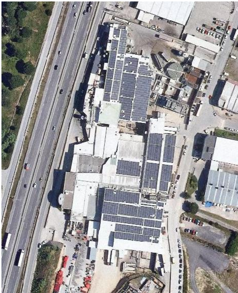
Figura 37: Detall de les cobertes de les naus, equipades amb panells solars fotovoltaics.
