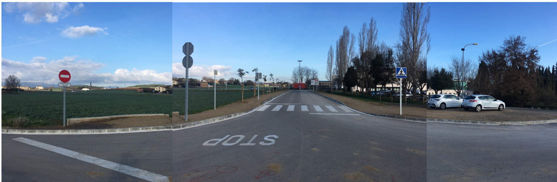
Sector 2: reserva de sòl per equipament del Nucli urbà. Vista del nou vial.
