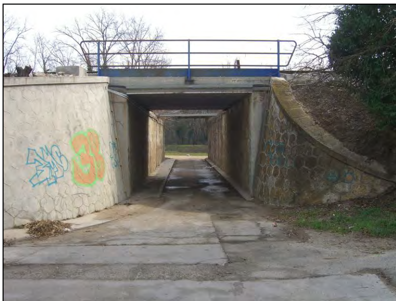
Pont existent sota el ferrocarril
