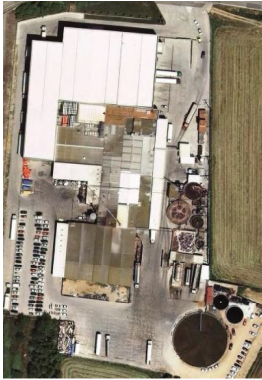
Vista actual de la indústria càrnia amb l'estació depuradora d'aigües residuals.
