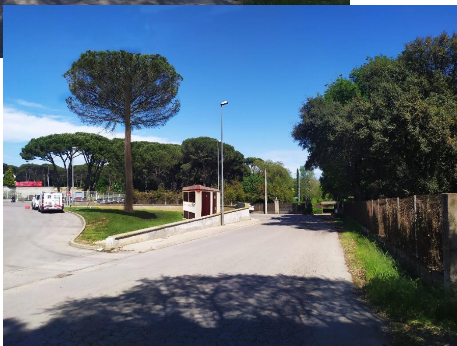
Fotografia: Eliminació del suport existent i substitució per la nova CM prefabricada.
