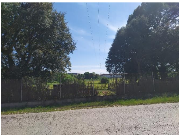
Imatge 4: Vista de la línia actual i suport T-56 on inicia la línia.
