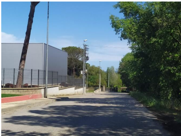
Imatge 3: Zona de creuament de la línia elèctrica soterrada
