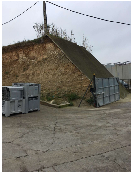
Figura 7. Vista del terraplén donde apoya el estribo Este
