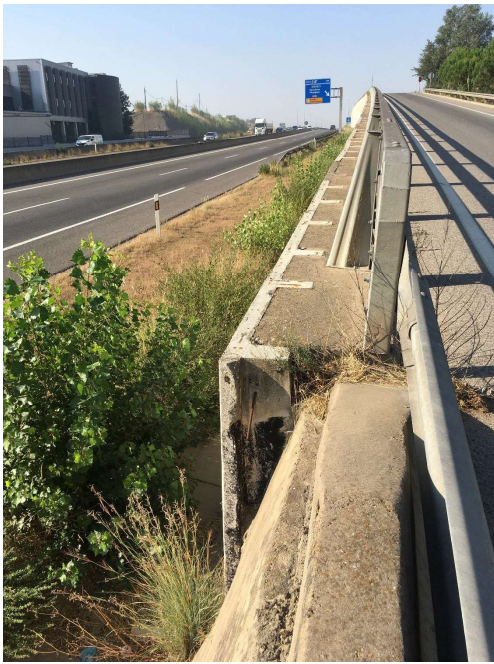
Figura 2. Vista del muro prefabricado que sostiene el vial de servicio sentido sur
