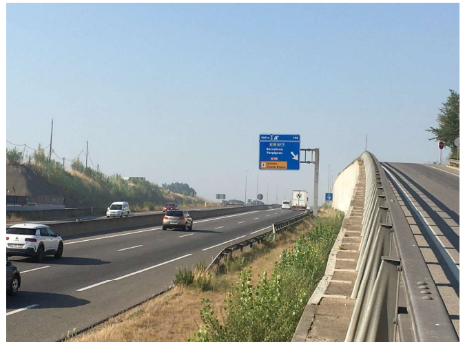
Figura 1. Vista de la A-2 en sentido sur
