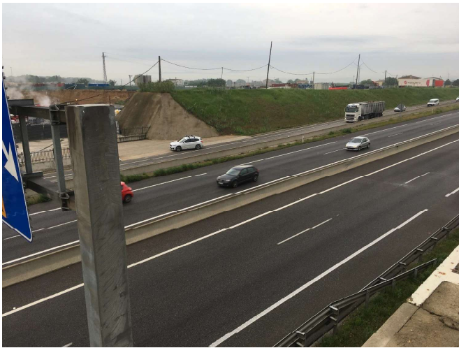
Figura 4. Vista desde el estribo situado al lado Oeste
