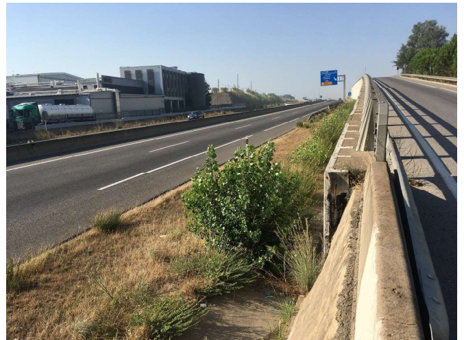
Figura 3. Vista de la A-2 y Friselda
