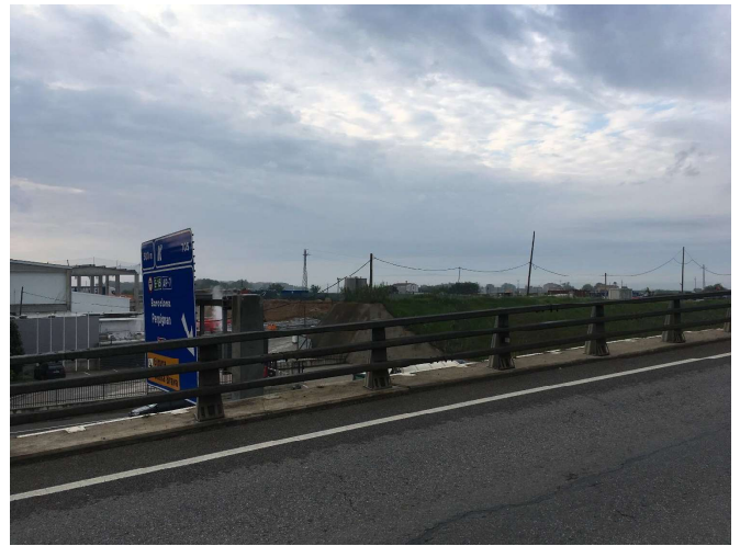
Figura 5. Vista del punto donde se ubicara el estribo del lado Oeste
