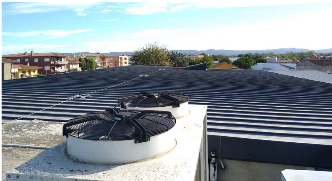
Fig. 4. Extrem Nord-Est de la coberta de l'Ajuntament
