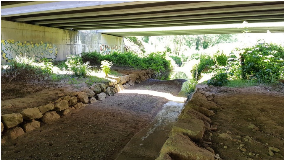
Imatge 9. Riera de Riudevila sota el pont de l'A-2
