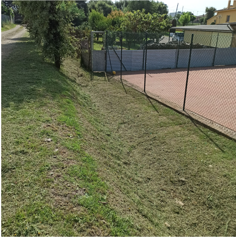
Imatge 4. Vista de la cuneta de terres existent en el tram inicial del camí des del polígon.
