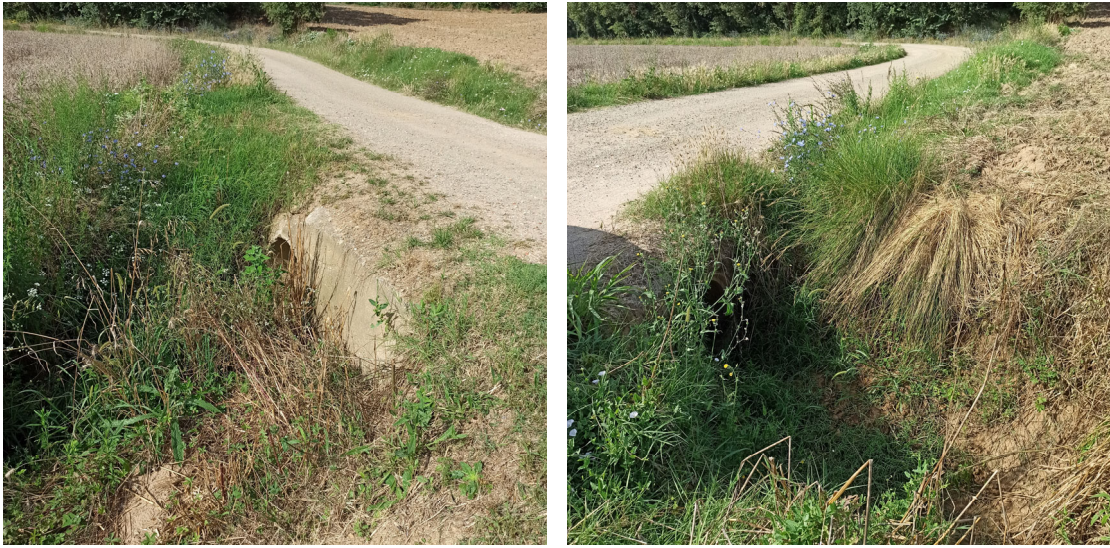
Imatge 10 i 11. Vista d'una obra de drenatge.
