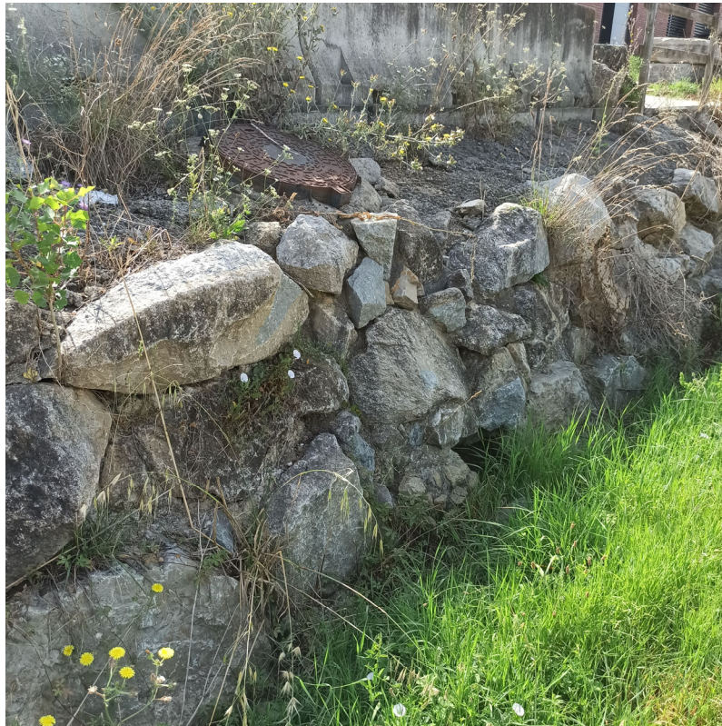
Imatge 7. Vista del drenatge de desemboca a la cuneta del camí.
