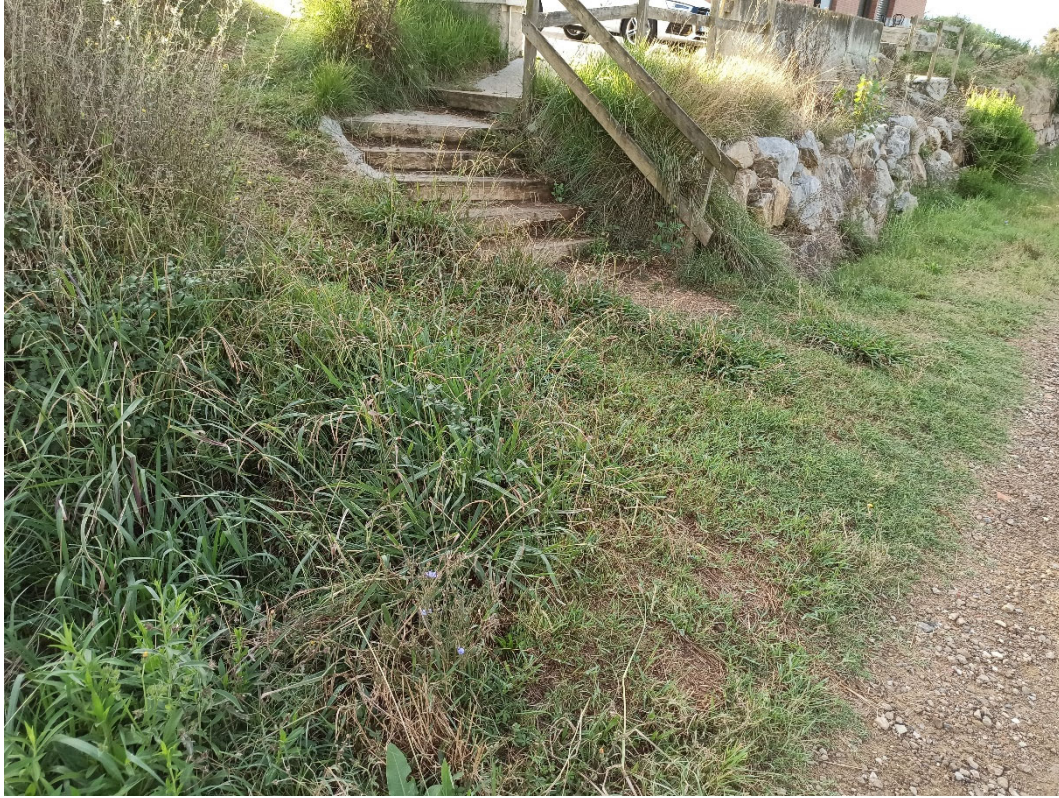
Imatge 6. Vista de l'accés al nou vial i escullera existent.
