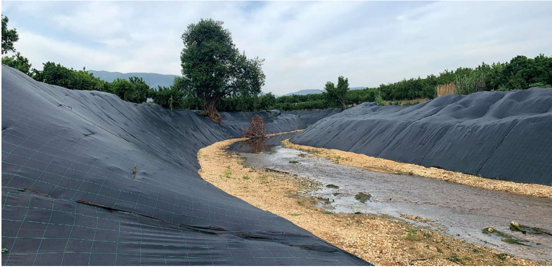
Imatge d'un marge de riera a on hi ha estès la malla antiherba
