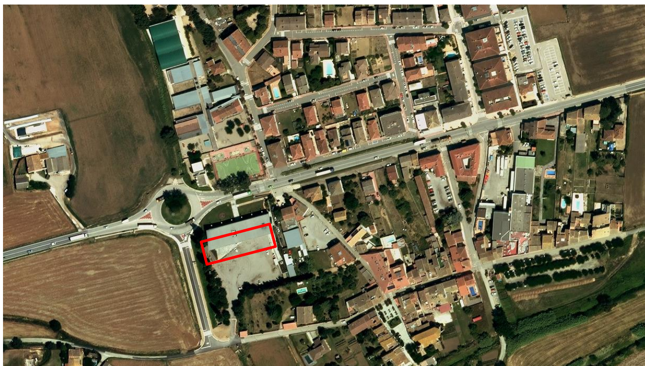
Fig. 5. Ubicació de les instal·lacions generadores sobre l'edifici afectat: Ajuntament de Riudellots de la Selva
