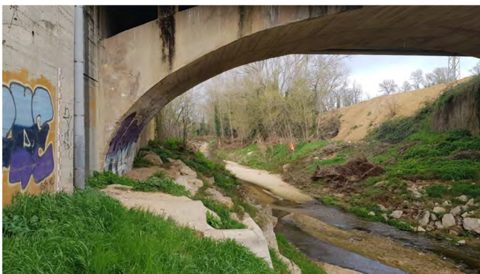
Imatge 5. Estat actual de l'àmbit del projecte sota el pont de la C-25
