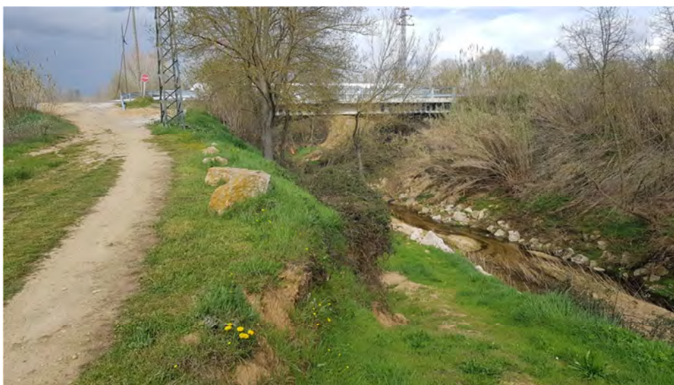
Imatge 4. Estat actual de la via verda al sud del pont de la C-25
