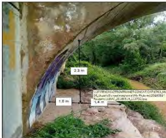
Imatge 6 Detall del mur lateral i volta de del pont. Mides aproximades. Vista aigua avall.
