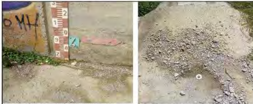
Imatge 4 Detall de l'escala limnimètrica en l'últim nivell del graonat, i de la base topogràfica existent.
