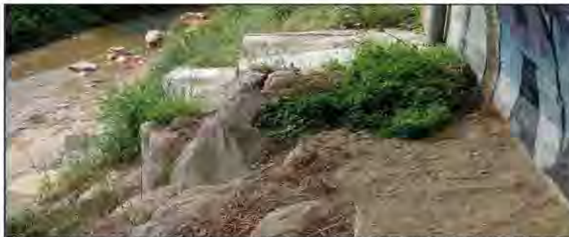
Imatge 7 Fonamentació, coronació d'escullera i plataforma de formigó a cota 3,66 de l'escala. Vista aigua amunt
