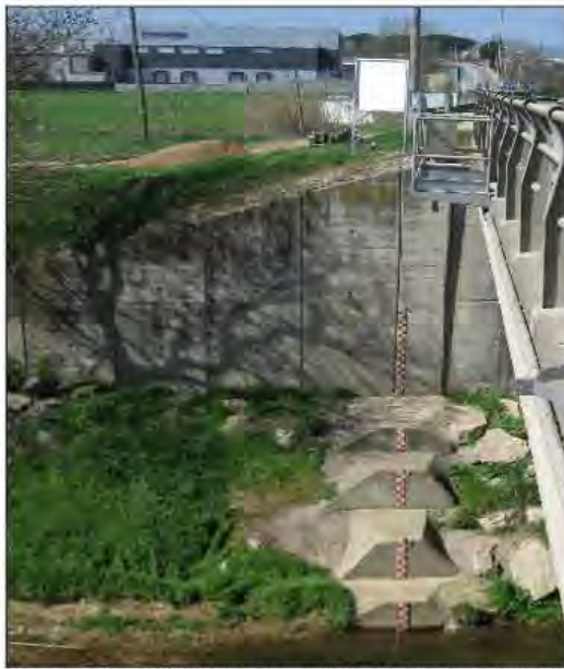
Imatge 3 Escala limnimètrica tramificada (marge esquerre)
