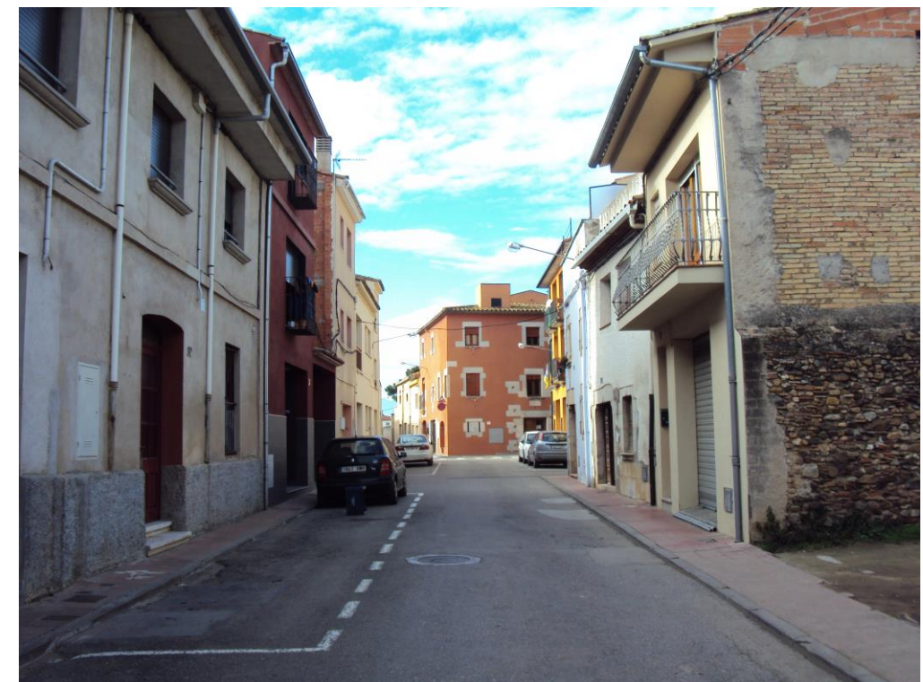
Foto núm. 12. Vista del carrer Major des del creuament amb carrer Baixada de les Acàcies.
