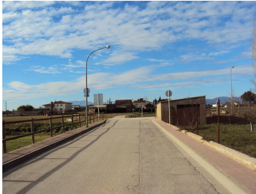
Foto núm. 17. Carrer Major nº 1
