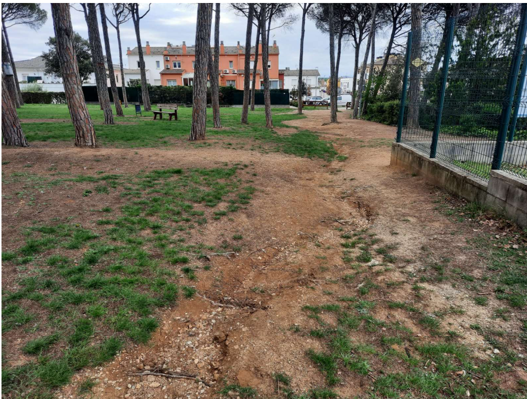
Entrada 1 del camp de futbol, inici paviment estabilitzat de 2 m d'amplada. Formigó ciclopi aigües amunt
