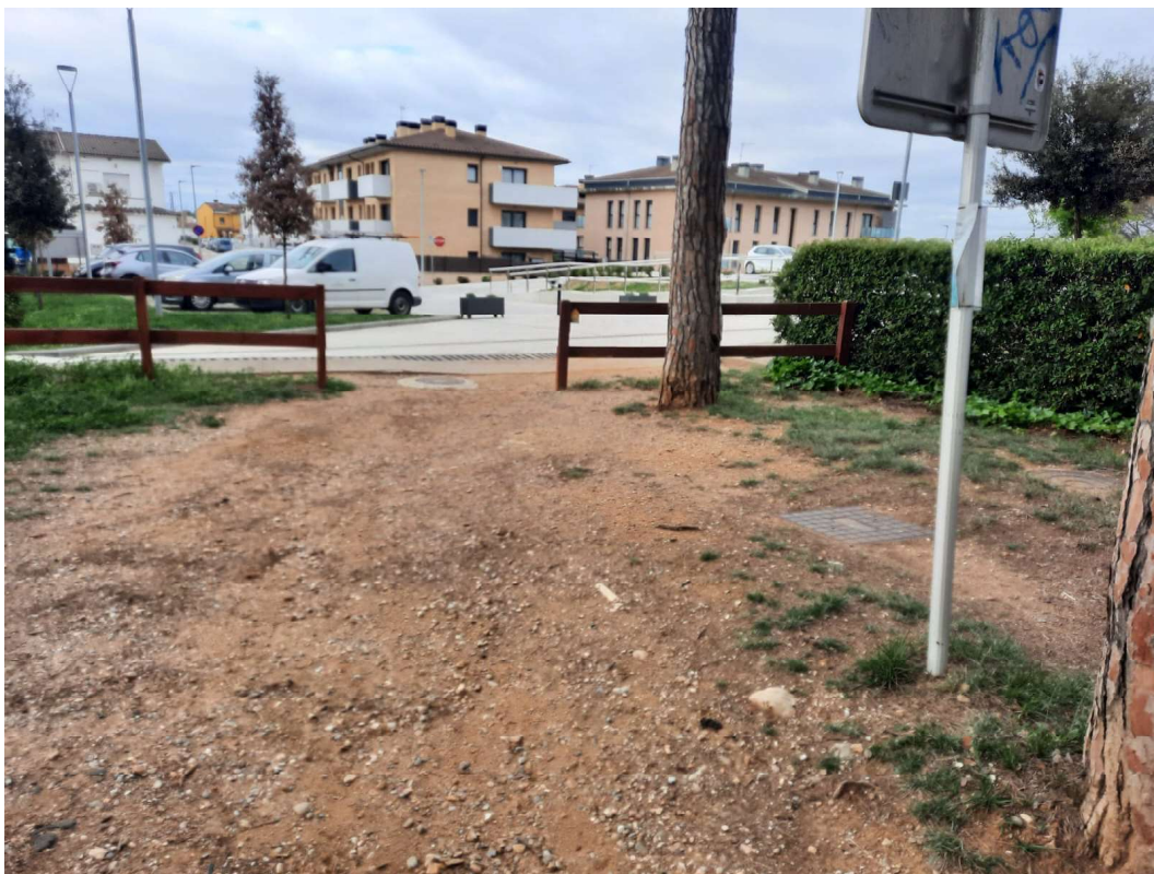
Entrada des dels accessos al pavelló municipal. Tapa de registre d'aixeta d'aigua potable dins el recorregut del camí. Tapes de registre a la dreta, de telefoni i baixa tensió. No s'intercepten.
