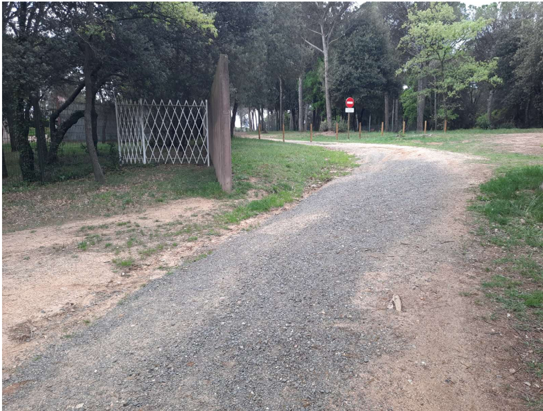
Condicionament de cuneta amb morter ciclopi. Paviment estabilitzat de 3 m d'amplada
