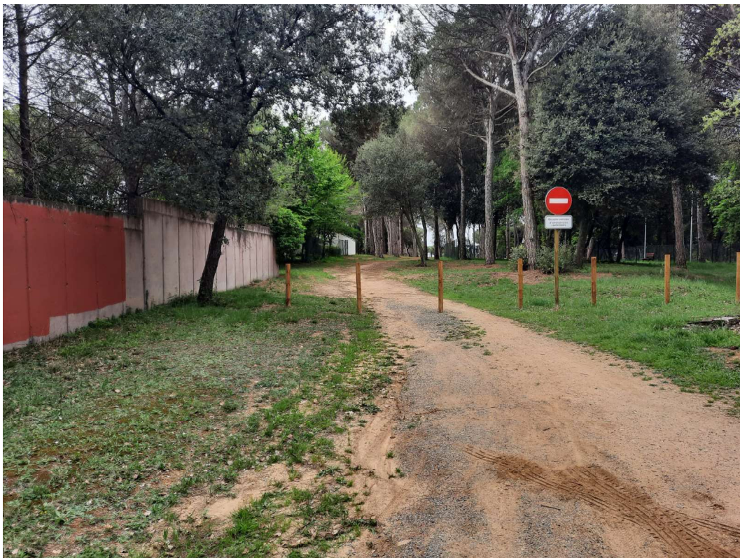
Paviment estabilitzat de 3 m d'amplada fins passades les pilones de fusta, fins acabar el mur del cementiri (95 metres en total)
