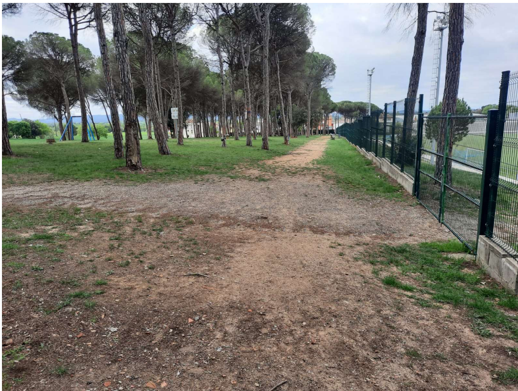
Zona entrada 2 del camp de futbol. Inici paviment estabilitzat de 2 m d'amplada fins a l'alçada de la tanca de fusta de vehicles. Formigó ciclopi aigües provinent entrada cementiri.
