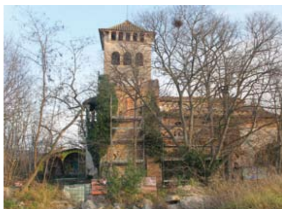
Rehabilitació de la Torre Na Joana
