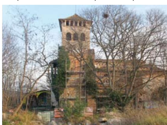
Rehabilitació de la Torre Na Joana
