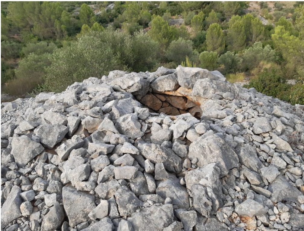
Vista de la pèrdua de la clau de volta
