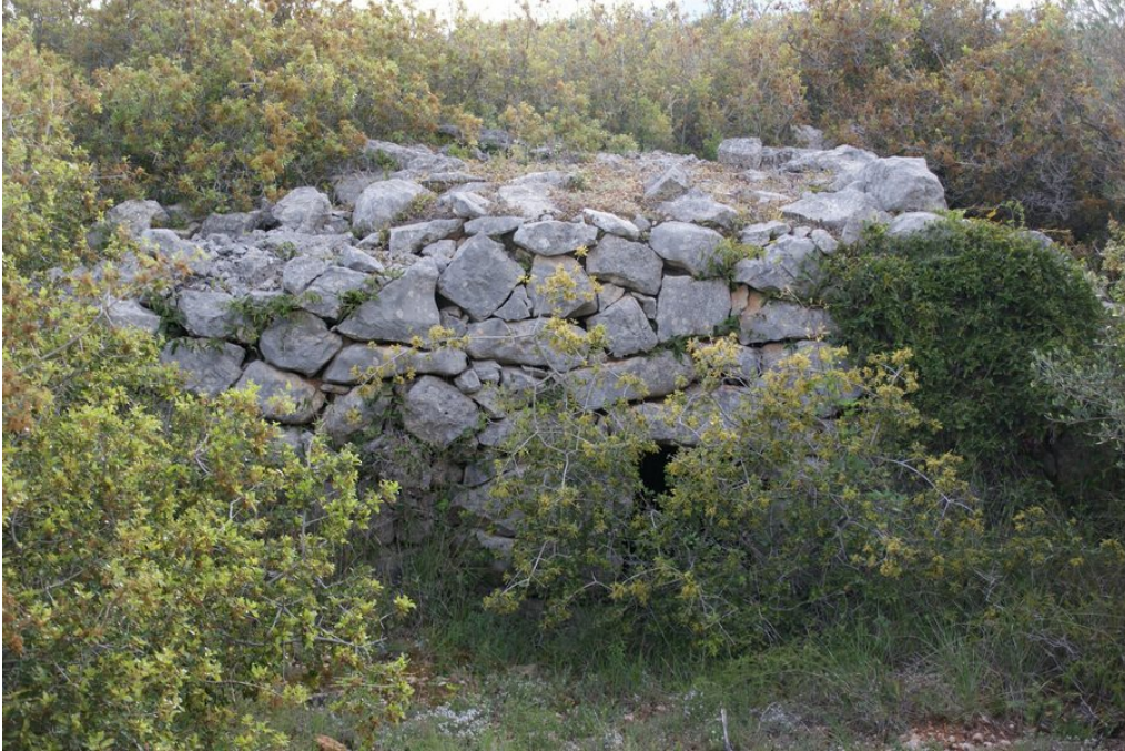
Vista de l'entrada
