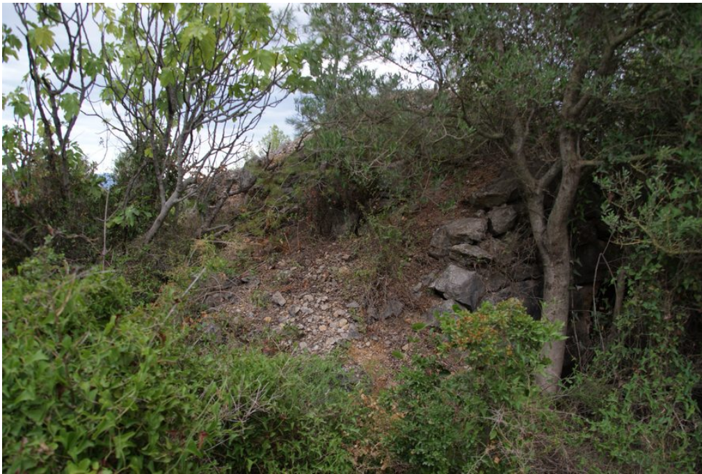
Vista dels esfondraments de la banda esquerra
