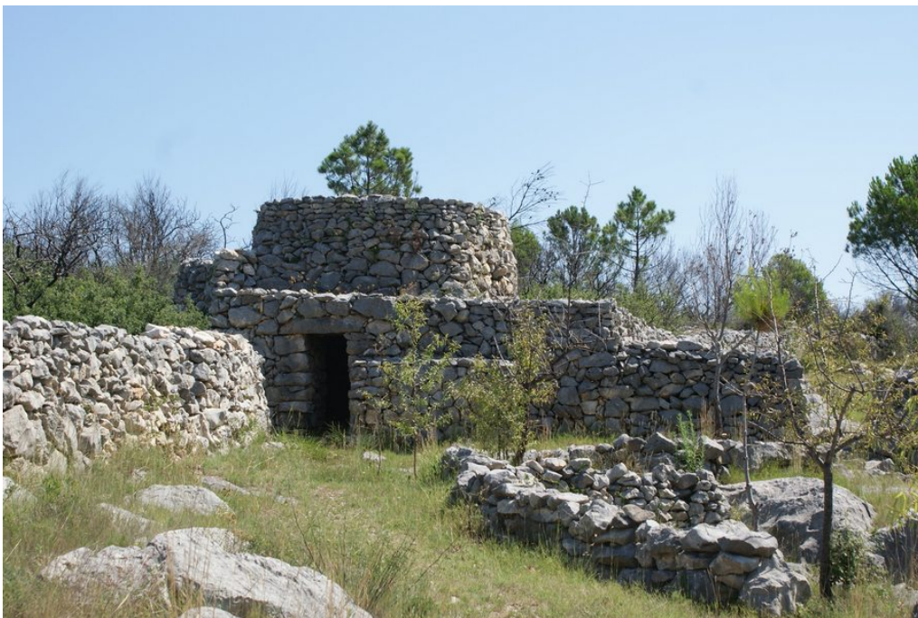
Vista general, on es pot apreciar el mur lateral esquerra i el mur dret amb funcions de contrafort
