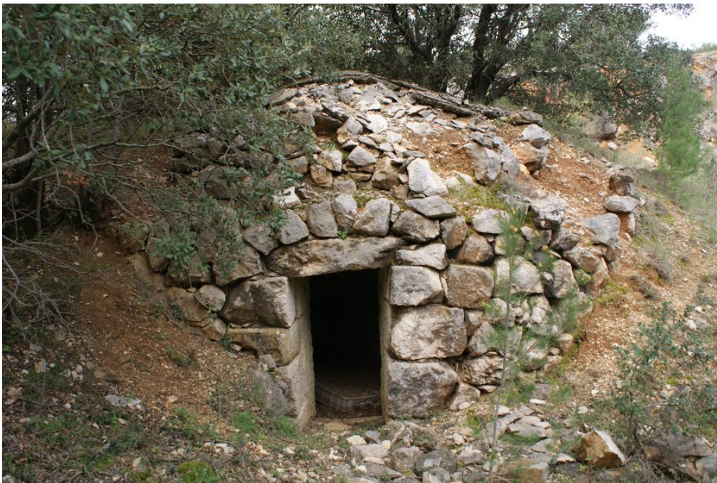
Vista de l'entrada on es poden apreciar els danys generals per ensorraments
