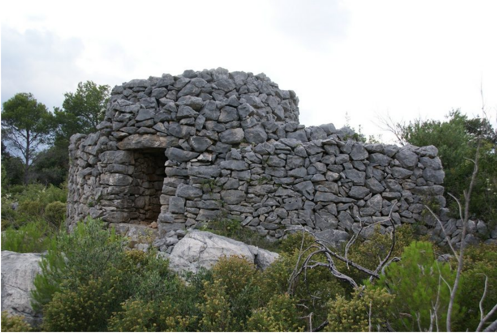
Vista de la façana lateral dreta, on es pot apreciar la dimensió del contrafort.
