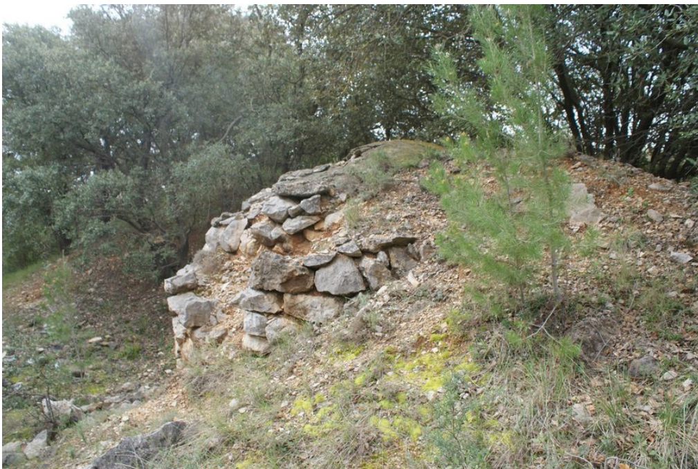
Vista de la banda dreta amb evidència dels desprendiments
