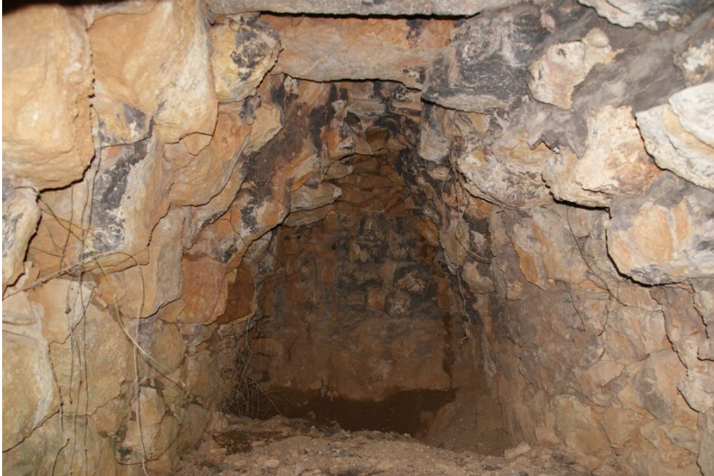
Vista del interior, amb els mur en pendent i les lloses de cobertura
