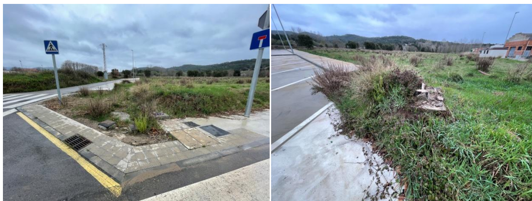
Zona d'actuació 1, amb vista de la zona a pavimentar i la fonamentació existent a enderrocar.
