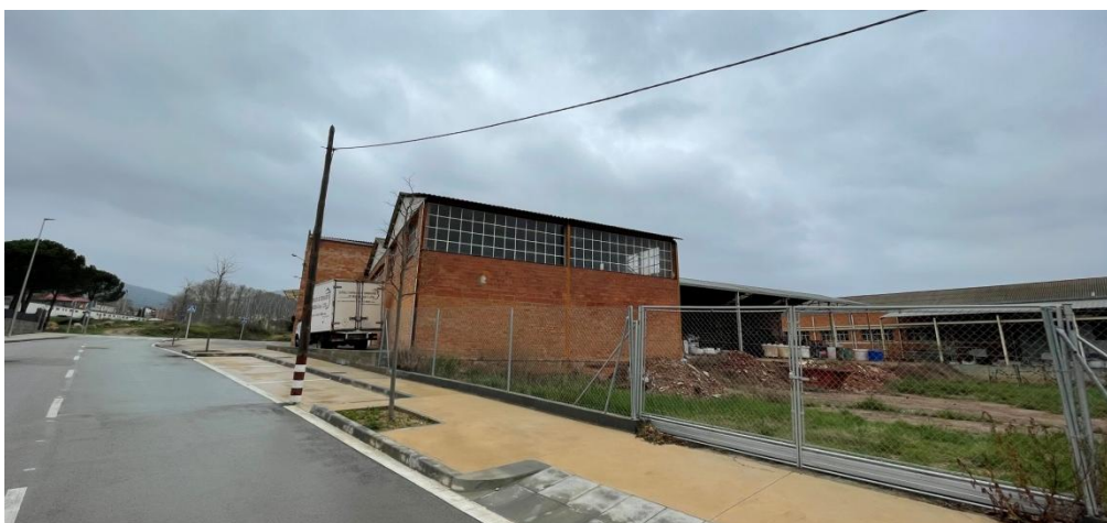
Pal de fusta i línia aèria telefònica a retirar
