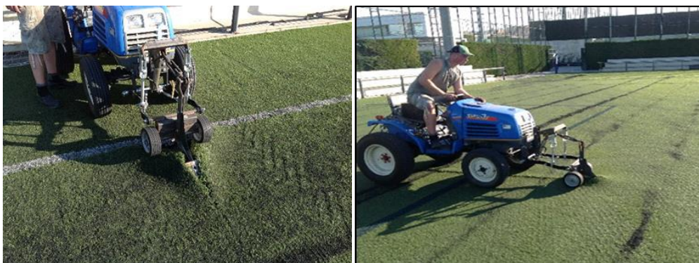
Tall del camp previ al desmuntatge
