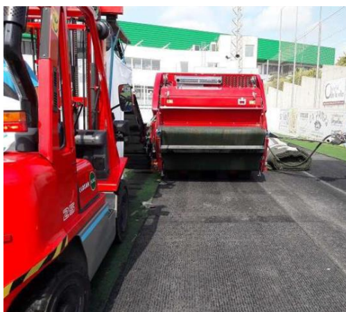
Utilització de la màquina especialitzada per a la separació de materials.
