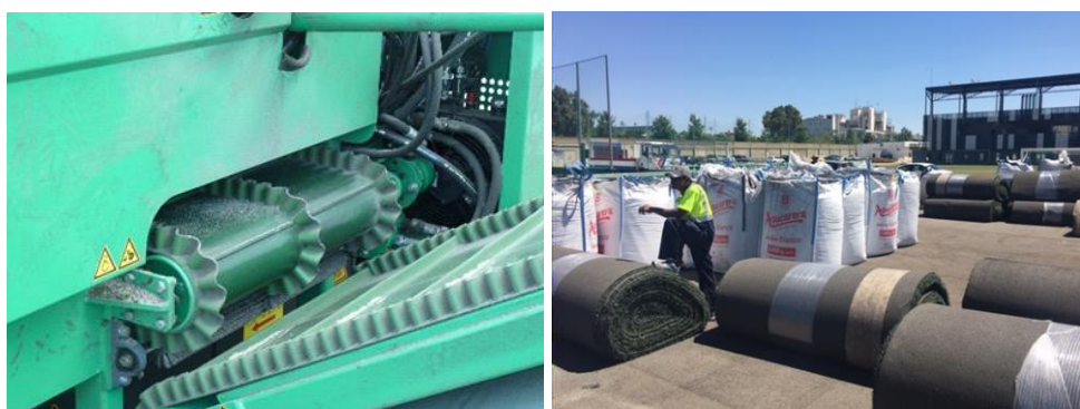
Imatges del procés d'enrotllat de la gespa artificial
