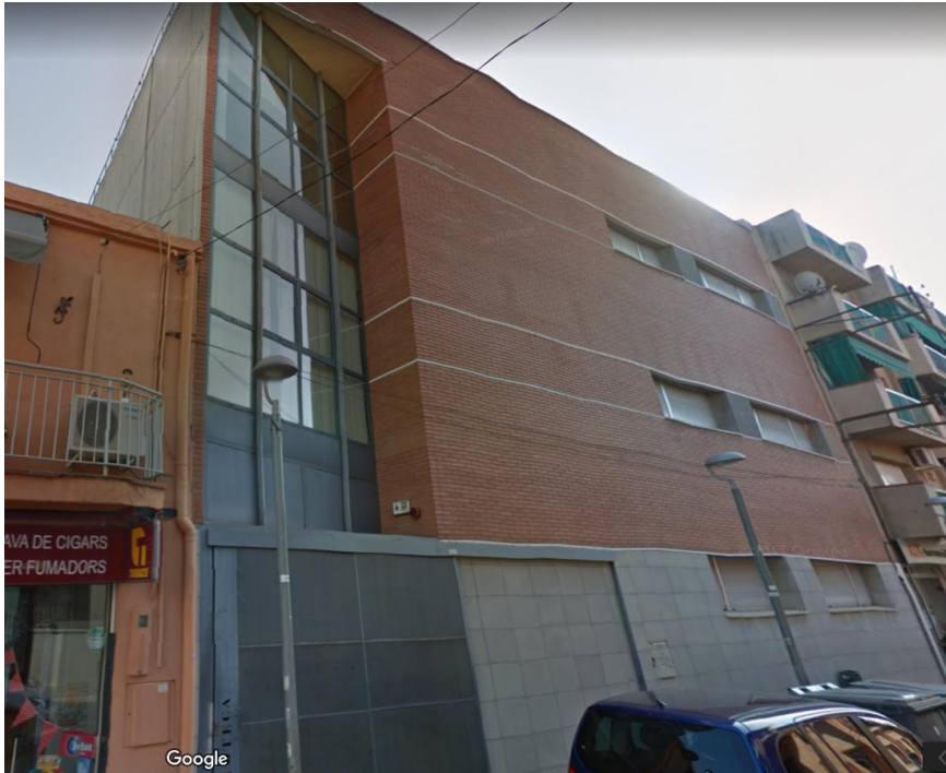
FOTO FAÇANA PRINCIPAL C/MOLI
