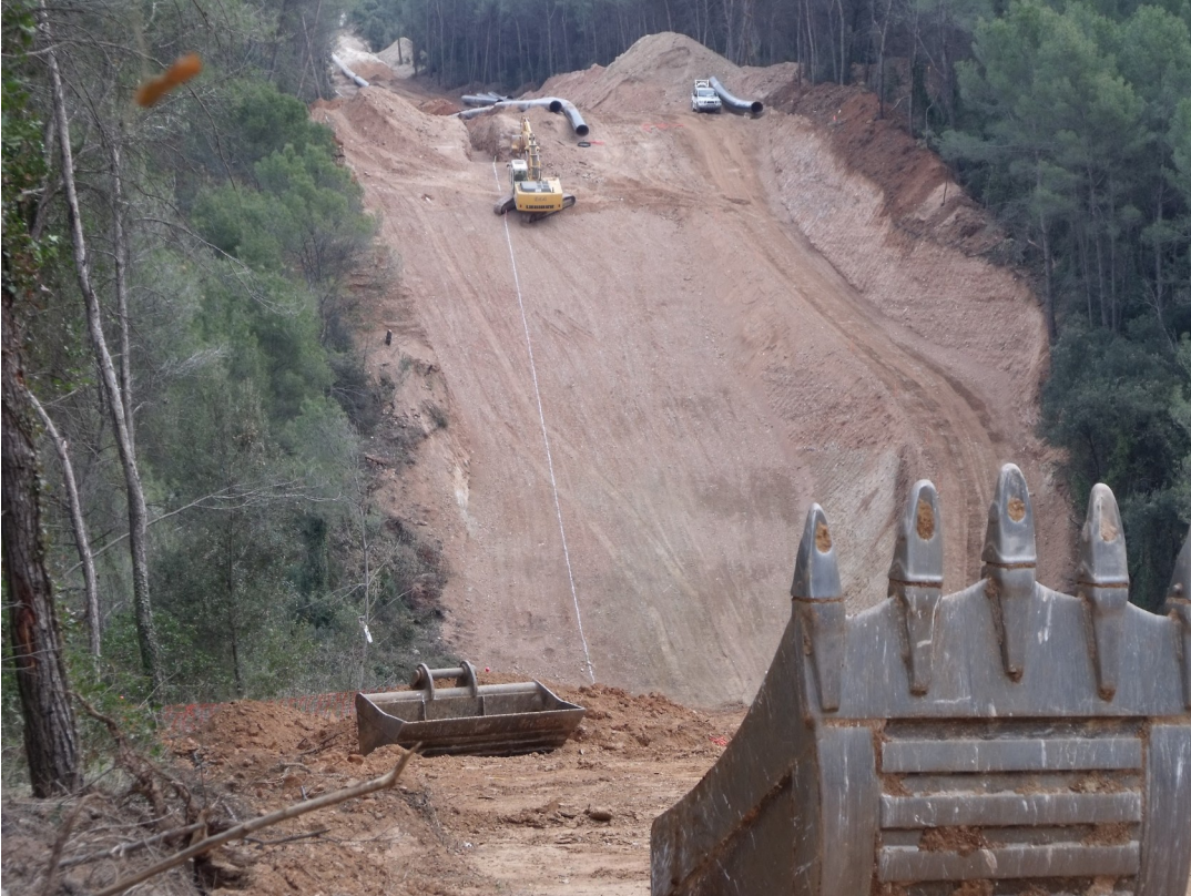
Imatge 2: fotografia presa durant la fase d'obres del primer tram a Castellar del Vallès.
