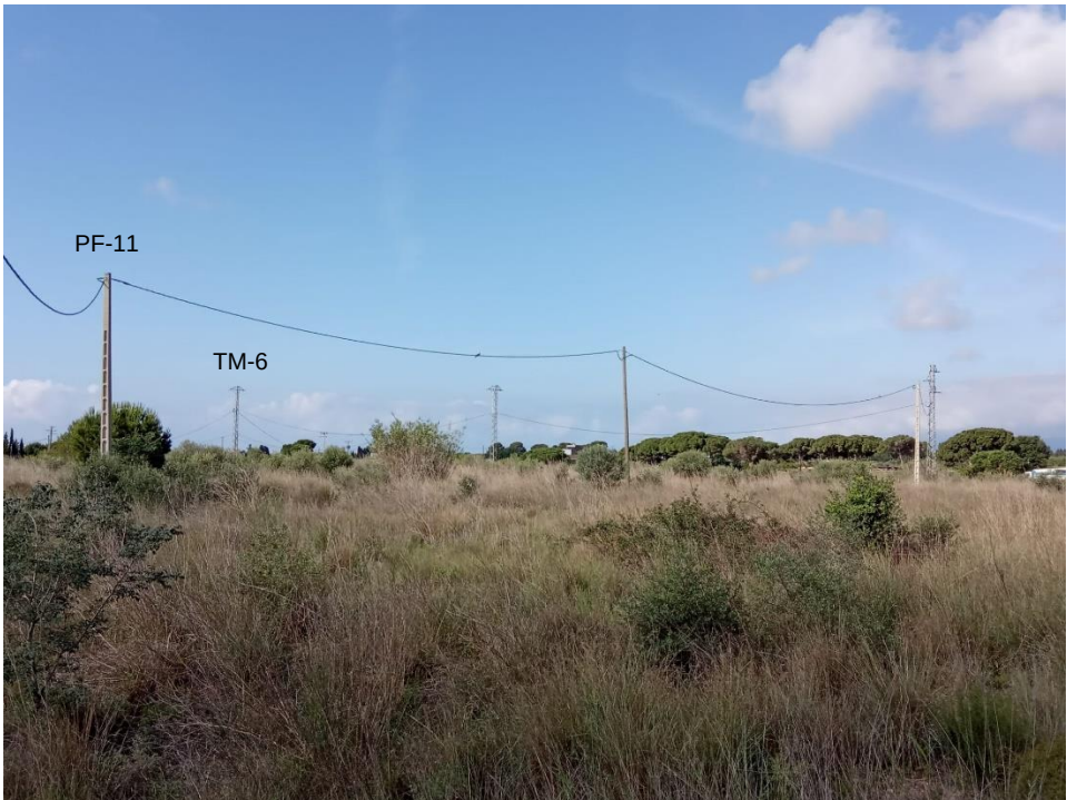
Foto8 . Tram entre suport PF-11 fins TM-6, a substituir conductor
