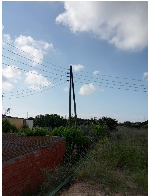
Foto4 . Suport PH-3, a substituir PM per PH 11/400
