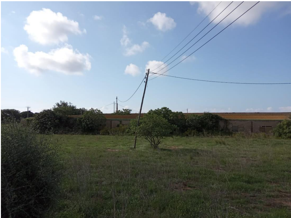
Foto6 . Suport PH-1, a substituir PM per PH 11/400
