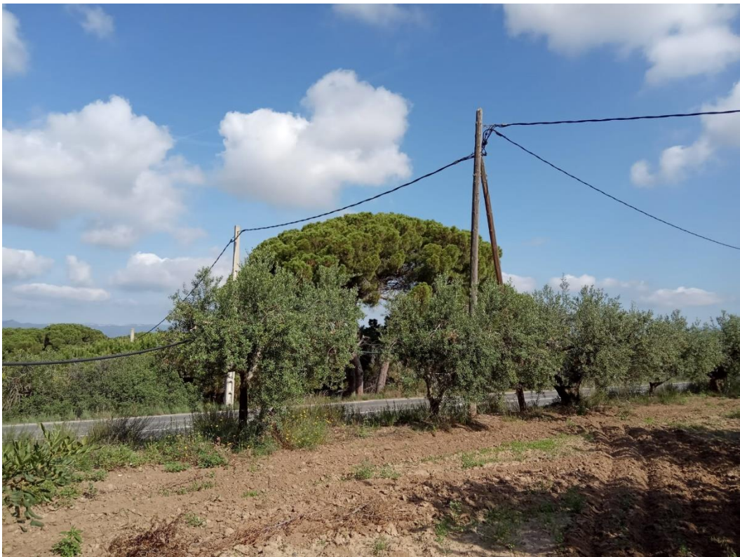
Foto9 . Suport PH-27, a substituir PM per PH 11/400
