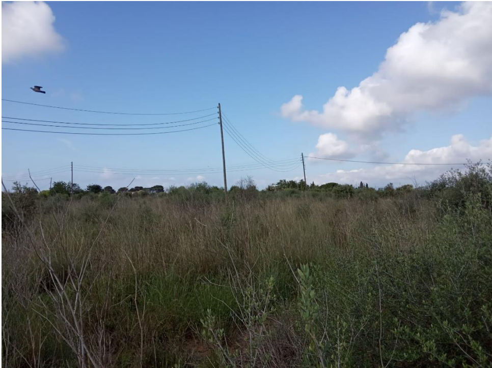
Foto5 . Tram entre suport PH-3 fins PH-2 a substituir
