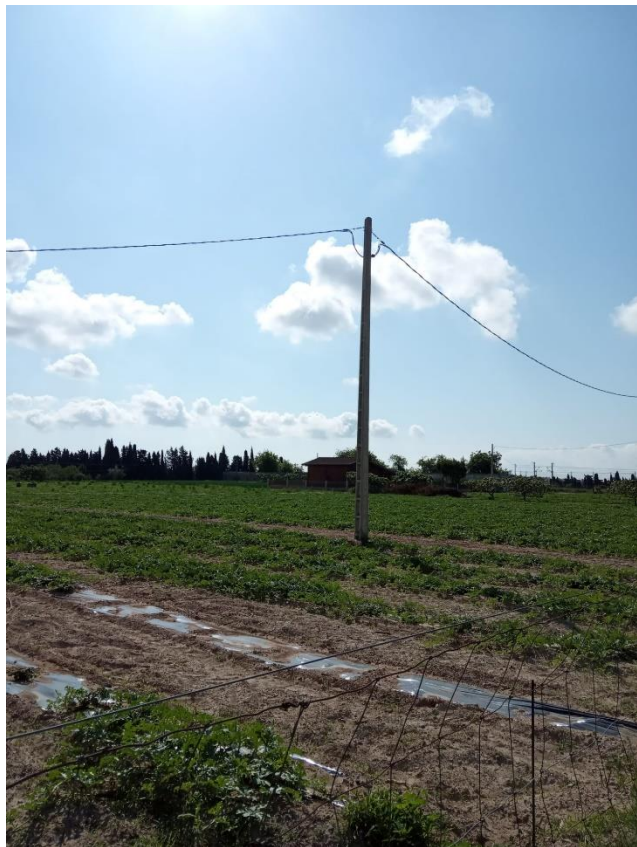
Foto12 . Suport PH-35, a substituir PM per PH 11/400
