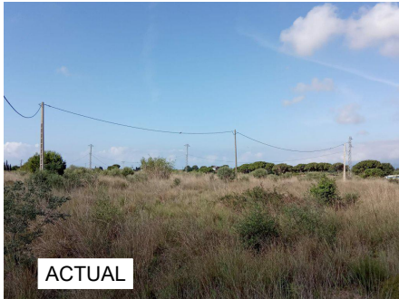
Tram entre suport PF-11 fins TM-6, a substituir conductor
