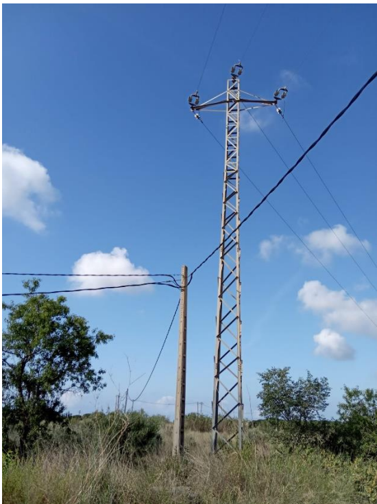
Foto7 . Suport PH-13, a substituir PM per PH 11/800
