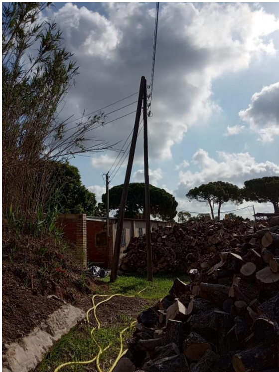
Foto1 . Suport PH-5, a substituir PM per PH 11/400
