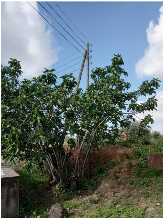
Foto2 . Suport PH-4, a substituir PM per PH 11/630
