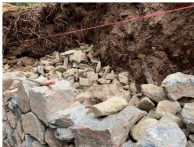
Imatge del reble de darrera el mur
