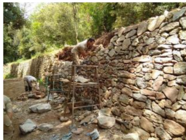
Durant els treballs de reparació
