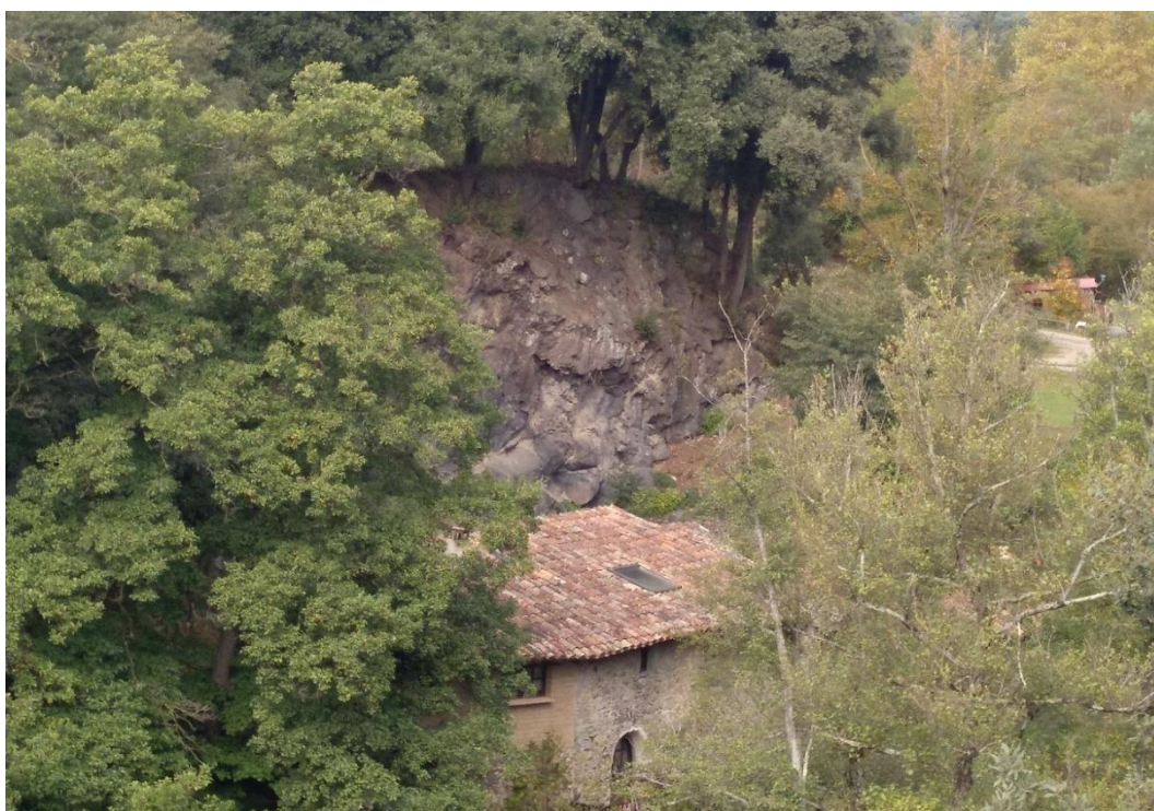
Fotografia 3. Cicatrius de desprendiments als materials volcànics alterats del tram superior de l'escarpament sobre Can Poetf.
