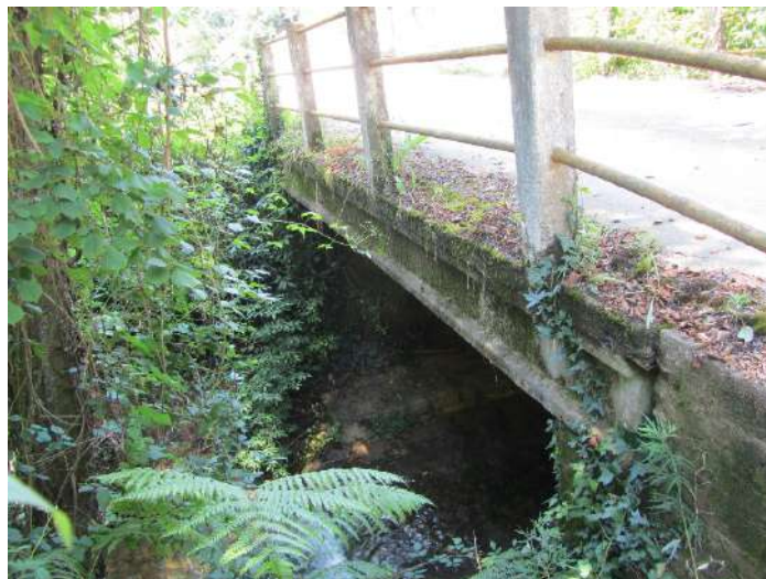
Estructura AV_04, torrent de l'Avellaneda, secció aigües amunt.
