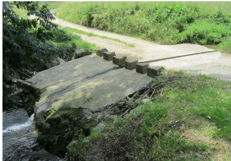
Estructura LLA_09, torrent de Llameca, gual en camí veïnal.
