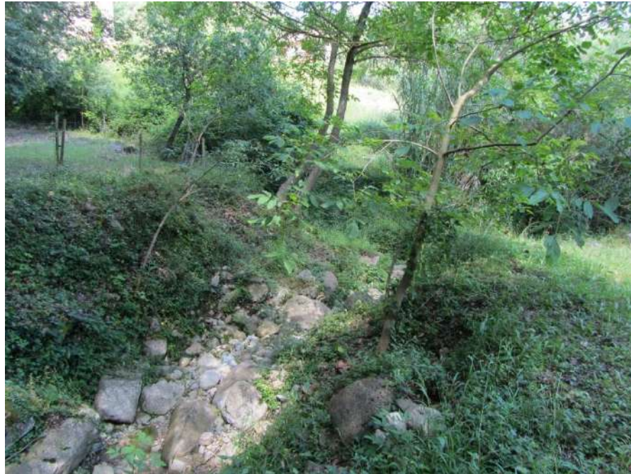
Vista de la llera del torrent de Vila, abans de confluència amb torrent Innominat_2.
