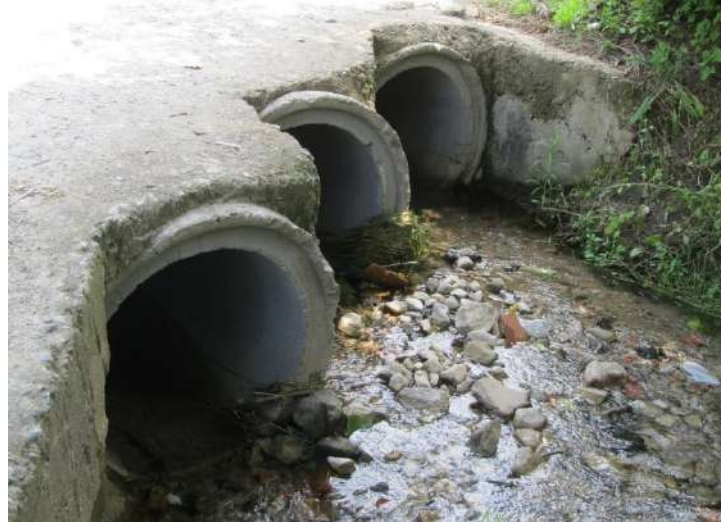
Estructura LLA_08, torrent de Llameca, secció aigües amunt.
