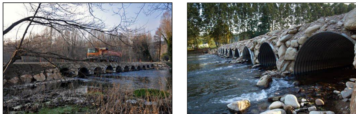
Vistes de l'estructura del gual provisional a la llera del riu Ter (destruït en la data de redacció del present projecte).
