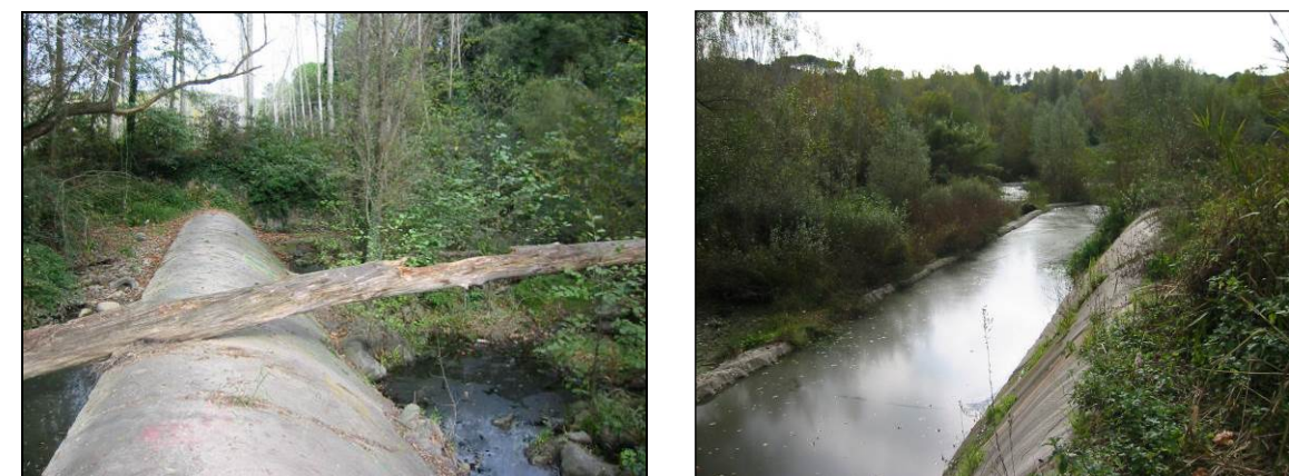
Imatges de l'estructura de la resclosa de la Pilastra existent a la llera del riu Ter.
