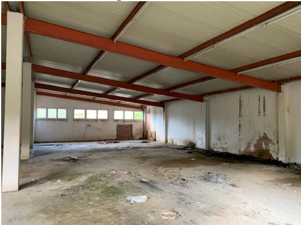
Foto 04_ Estructura coberta a substituir
