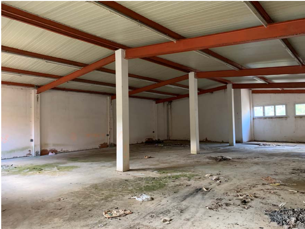
Foto 03_ Estructura coberta a substituir
