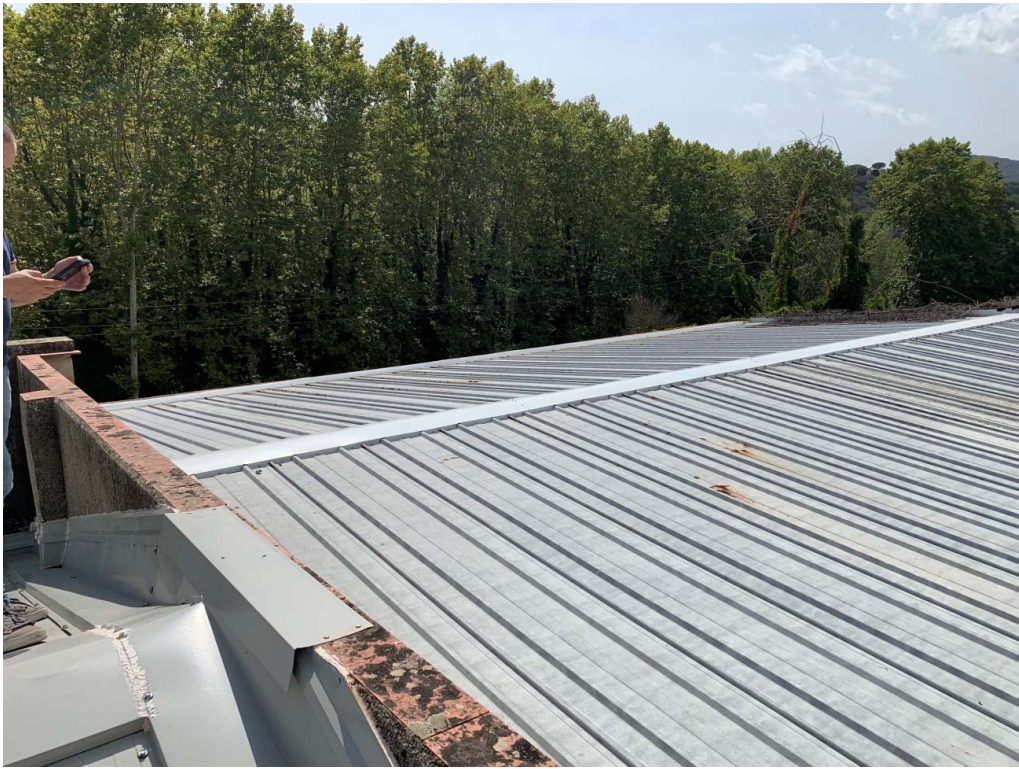
Foto 05_ Coberta a substituir
