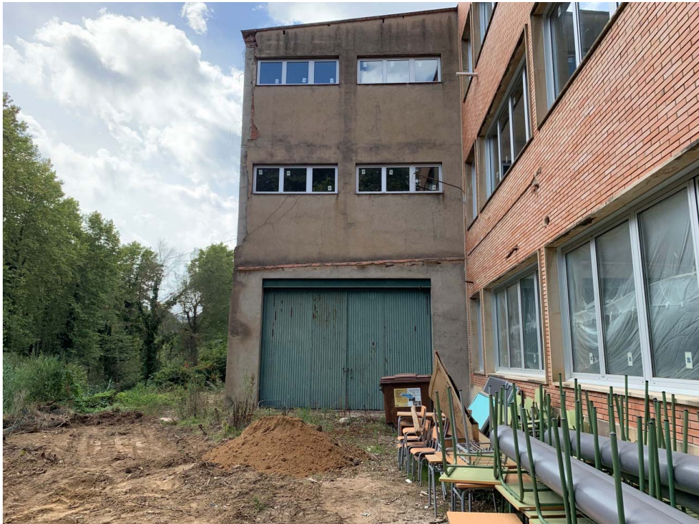
Foto 01_ Façana i porta P2 a substituir
