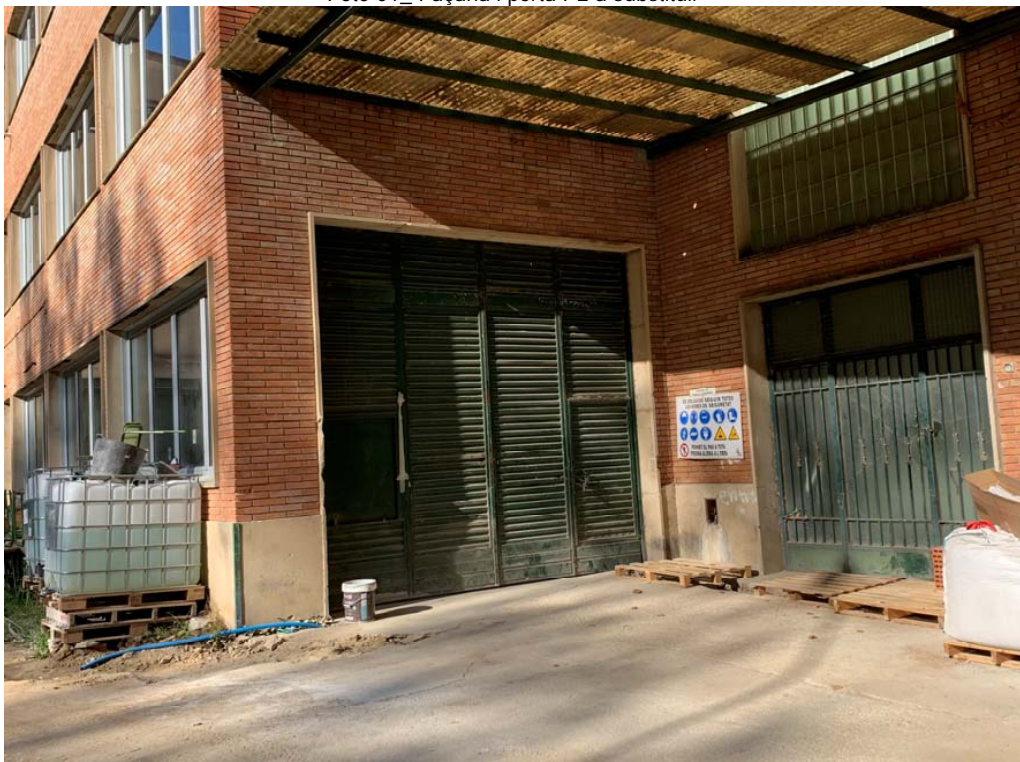
Foto 02_ Façana i porta P1 a substituir
