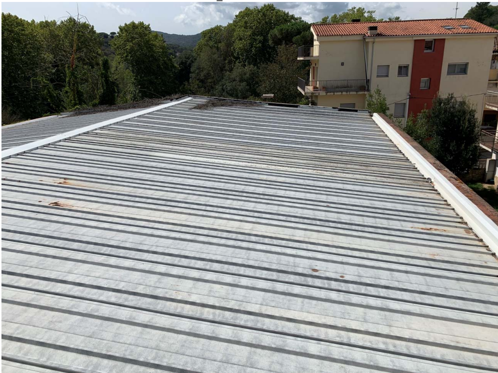
Foto 06_ Coberta a substituir
