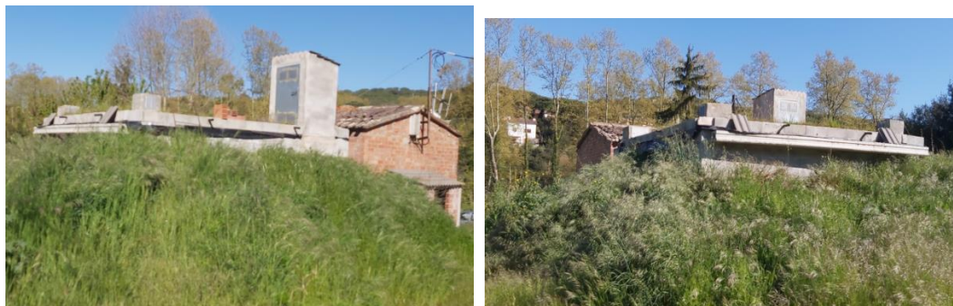
Figura 18. Imatge dipòsit exterior
