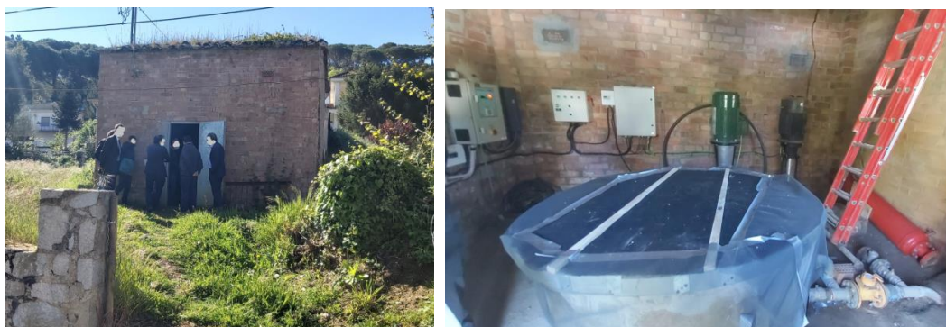
Figura 13. Caseta i Pou.
