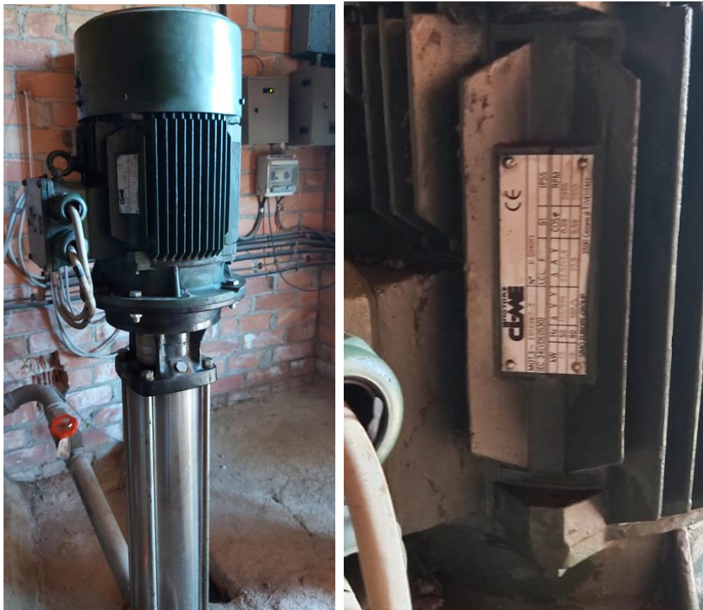
Figura 38. Bomba eix vertical CIME
