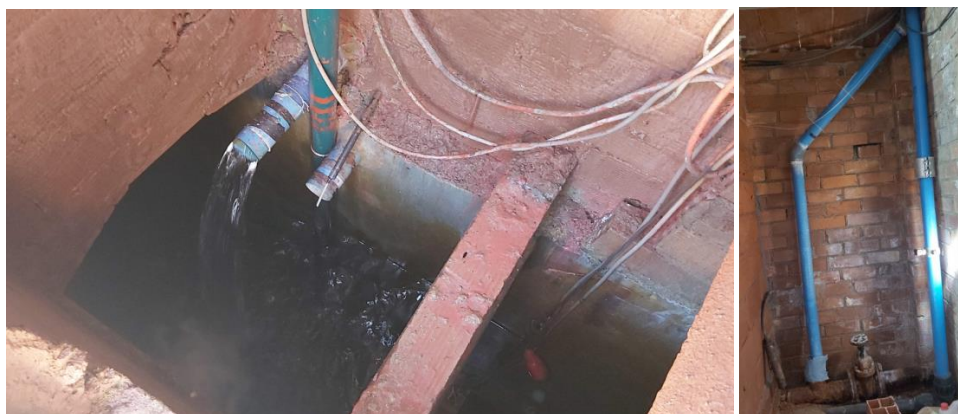
Figura 41. Entrada d'aigua i boies de nivell.
