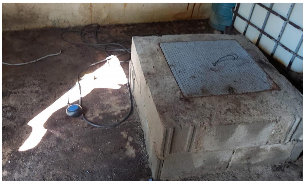
Figura 26. Arqueta pou piscina
