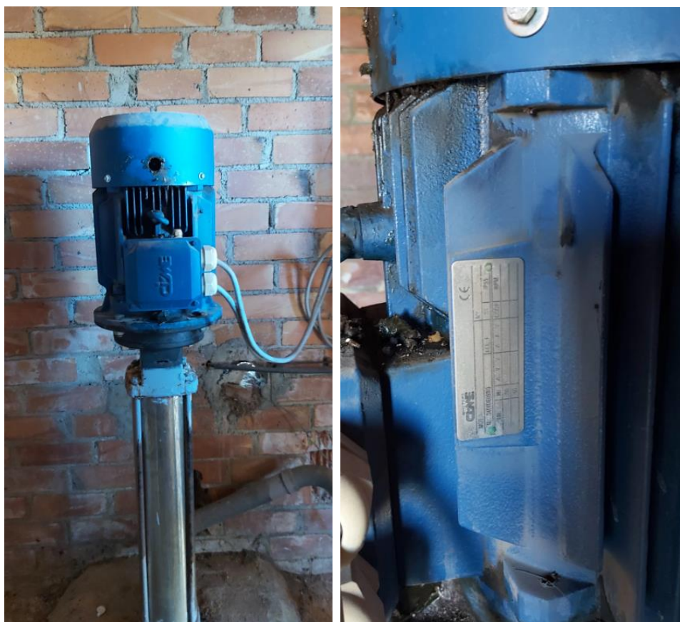
Figura 37. Bomba Eix Vertical CIME
