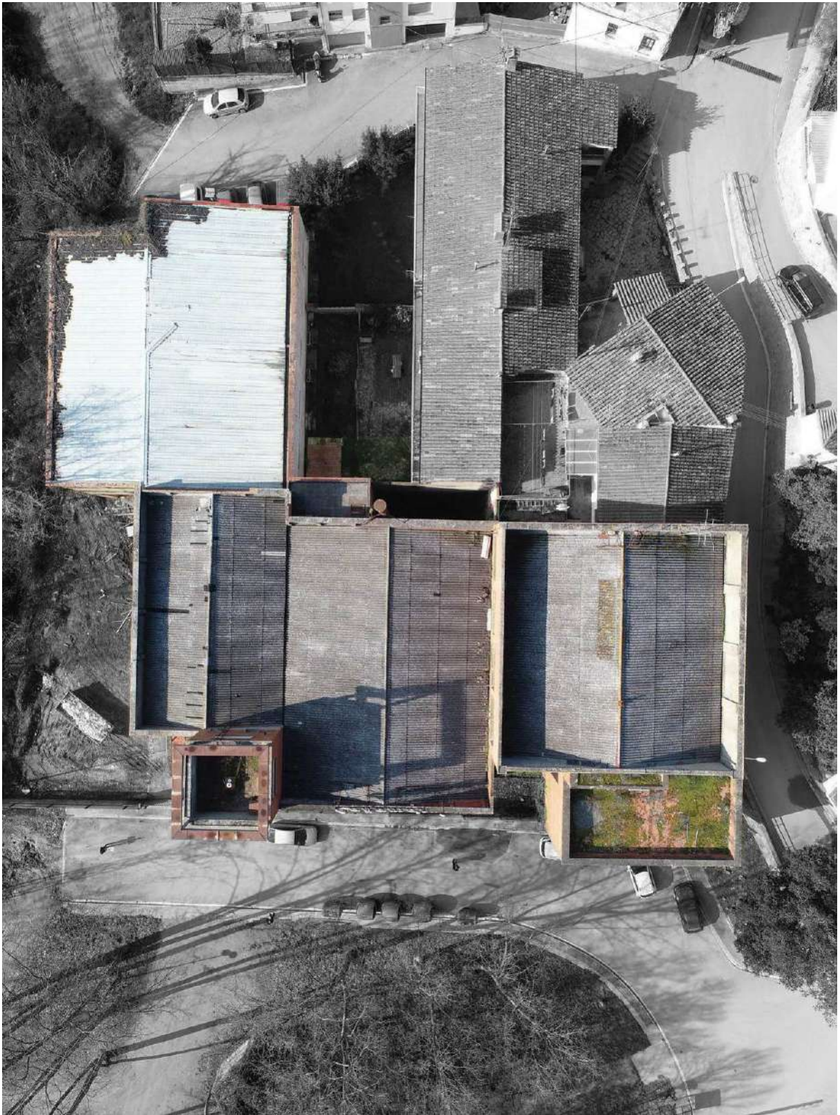
Foto aèria de la coberta de l'edifici actual, on s'hi veuen els quatre grans cossos que el formen.
