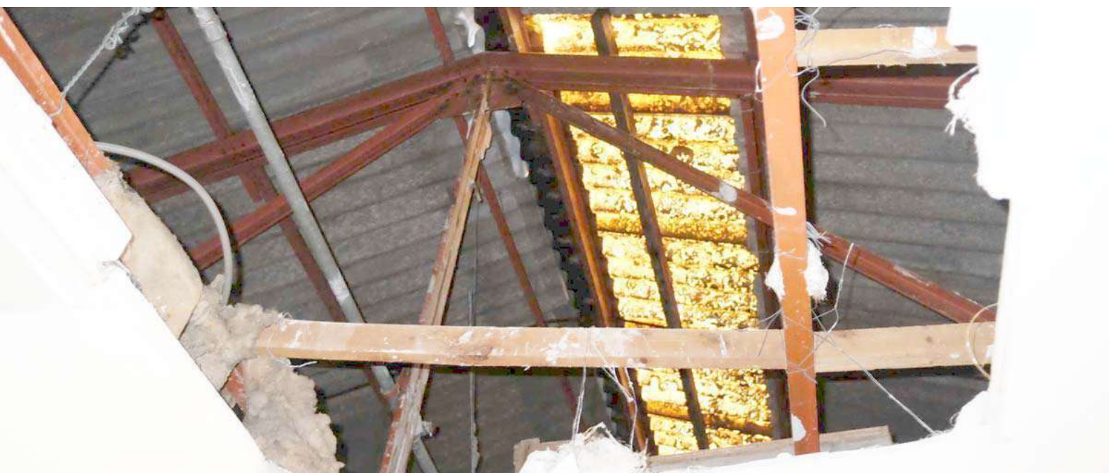
Estructura d'encavallades i biguetes metàl·liques a la coberta del nivell 3, zona més antiga.
