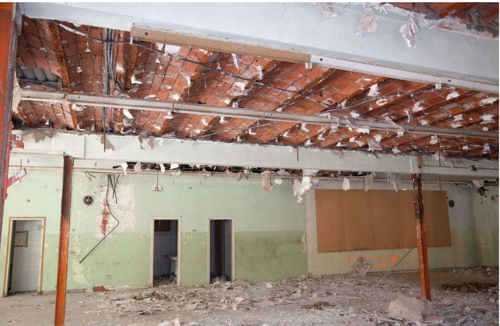
Estructura de bigues, jàsseres i pilars metàl·lics nivell 2
