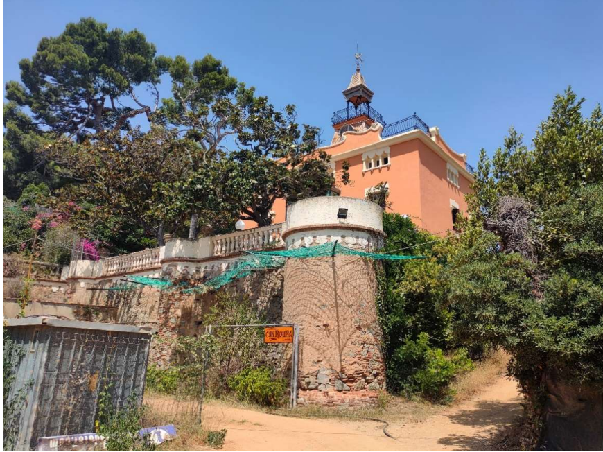
Mur de maçoneria i torres circulars
