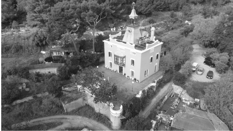
Imatge actual de la terrassa i el mur de contenció de Can Tarrida
