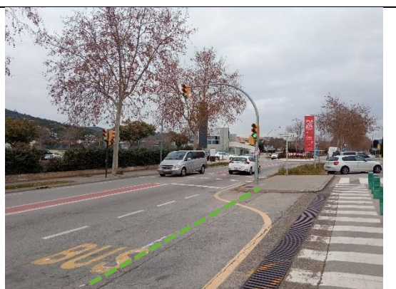
Canalització existent entre el bàcul semafòric i el propi regulador
